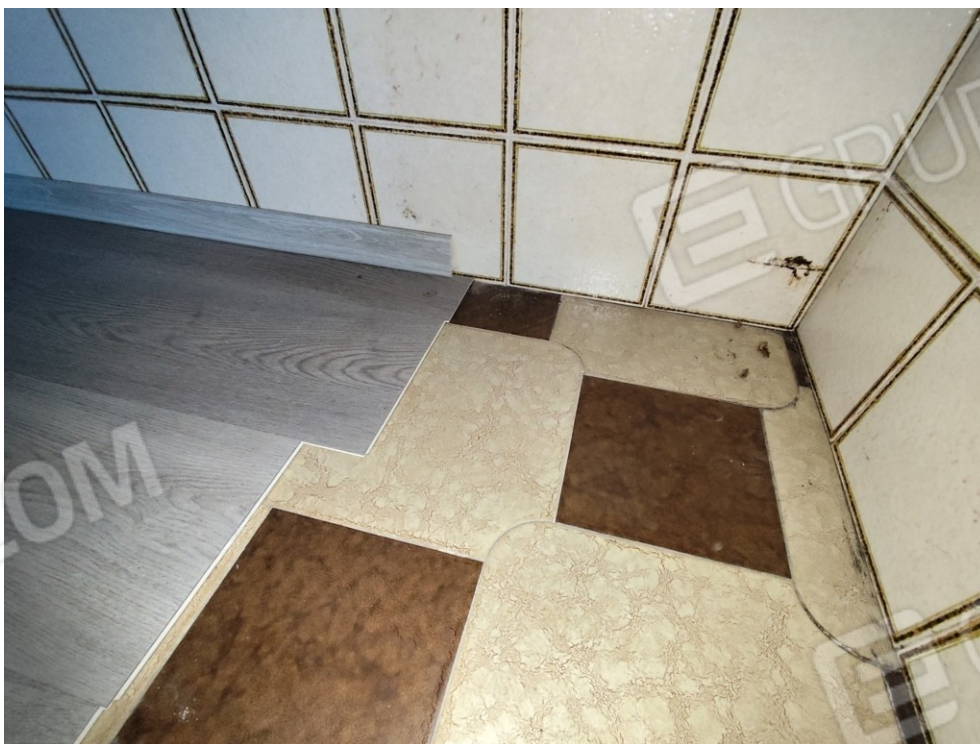
1.6 – cucina - particolare pavimento
