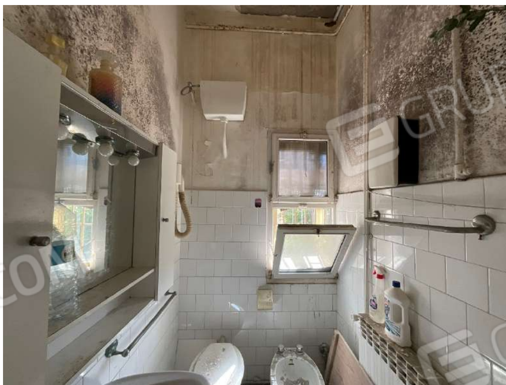
Bagno al piano terra abitazione
