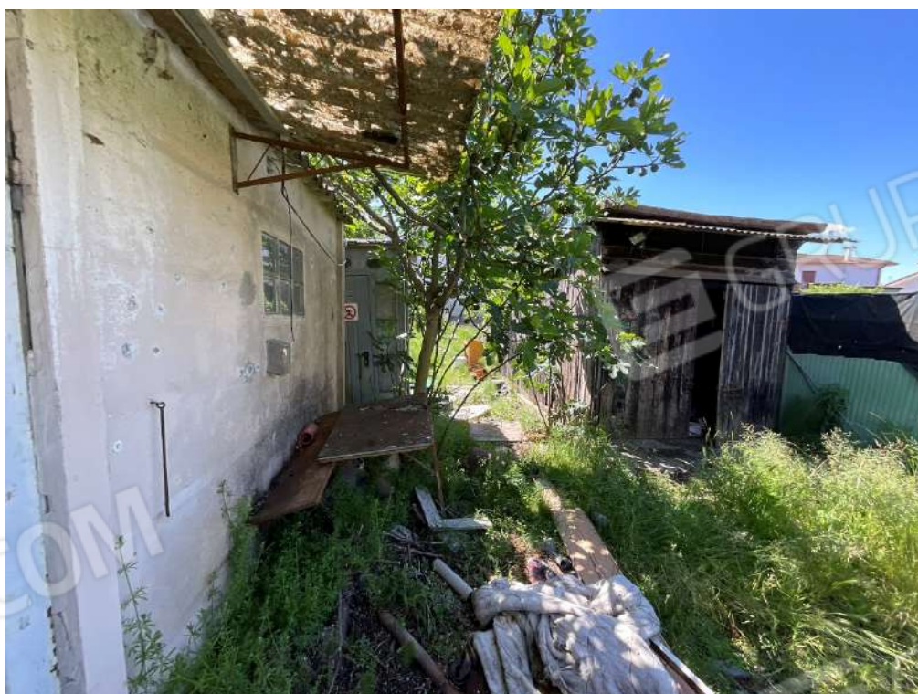
Corte con prospetto autorimessa
