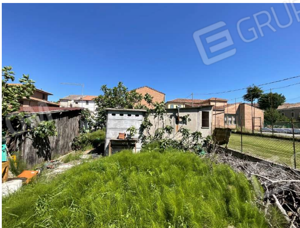
Prospetto visto dalla corte
