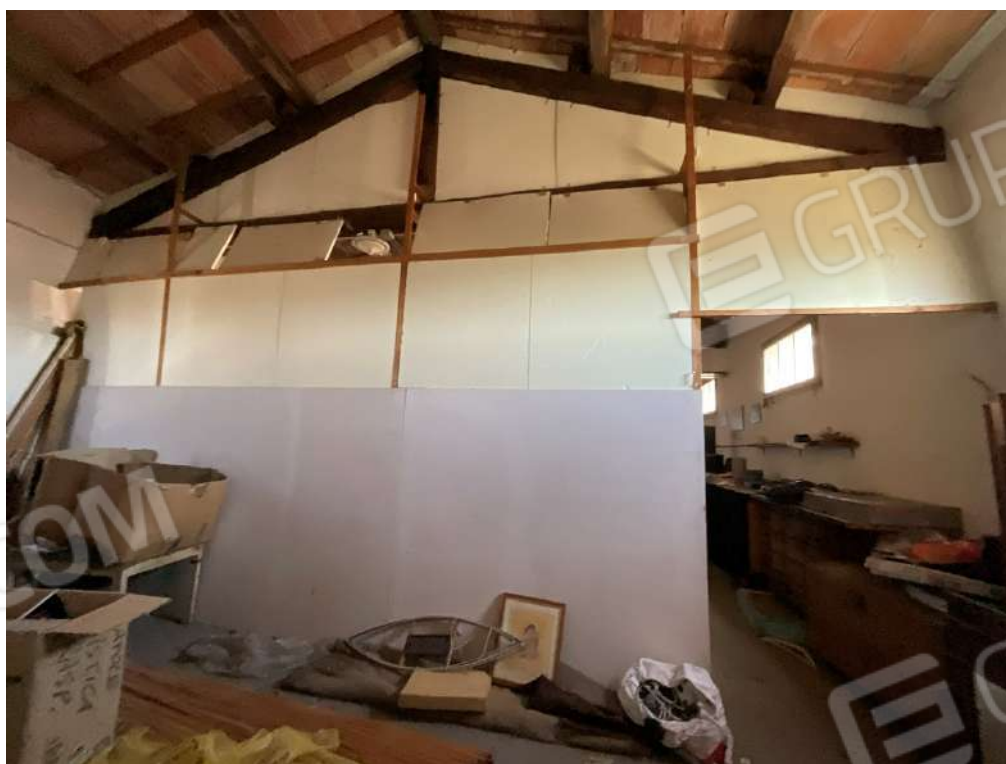
Parete divisoria in legno da demolire
