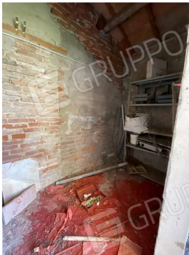
Locale ripostiglio retro magazzino pt
