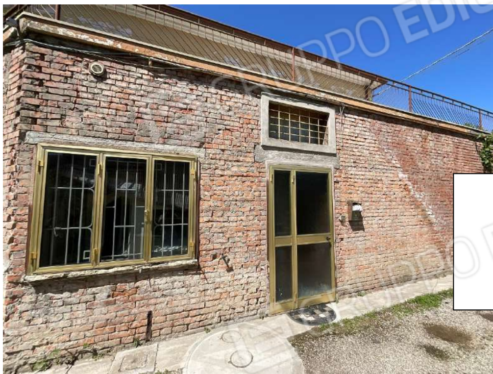
Prospetto ingresso abitazione con terrazzo al piano primo
