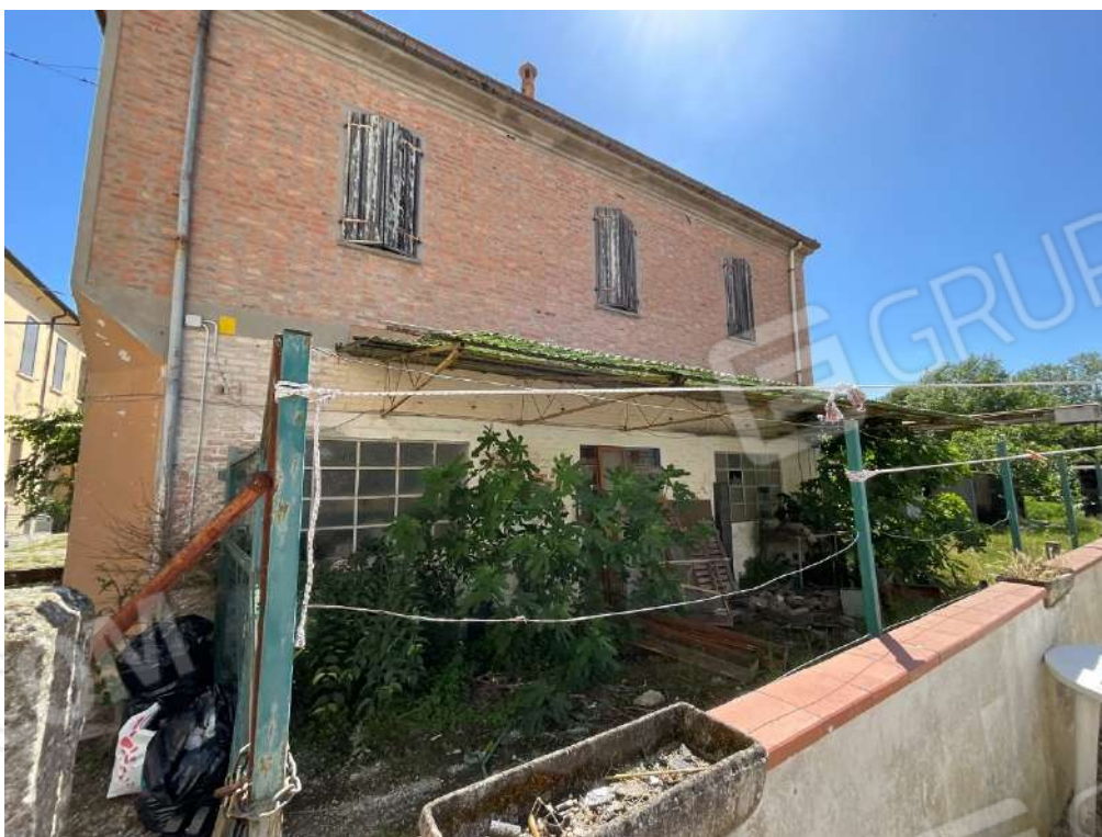
Prospetto ovest magazzino con tettoia e accesso con cancello alla corte recintata
