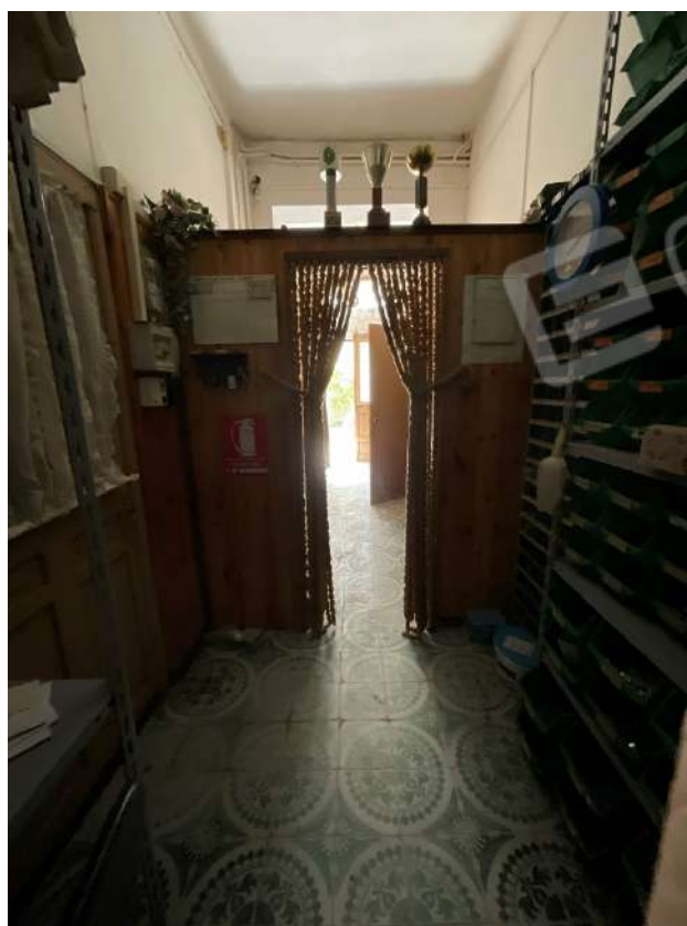
Parete in legno divisorio con tenda nel corridoio ingresso abitazione da demolire
