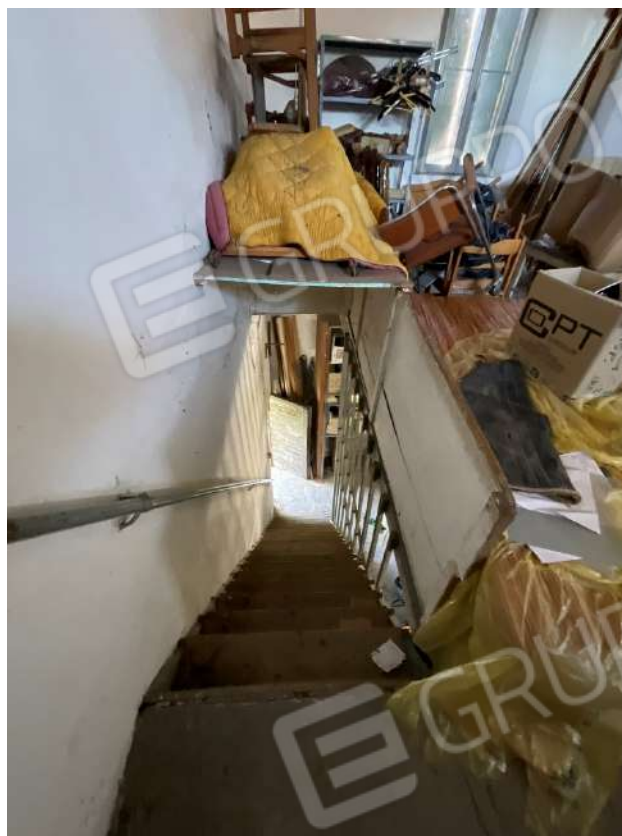
Scala magazzino di collegamento tra piano terra e primo
