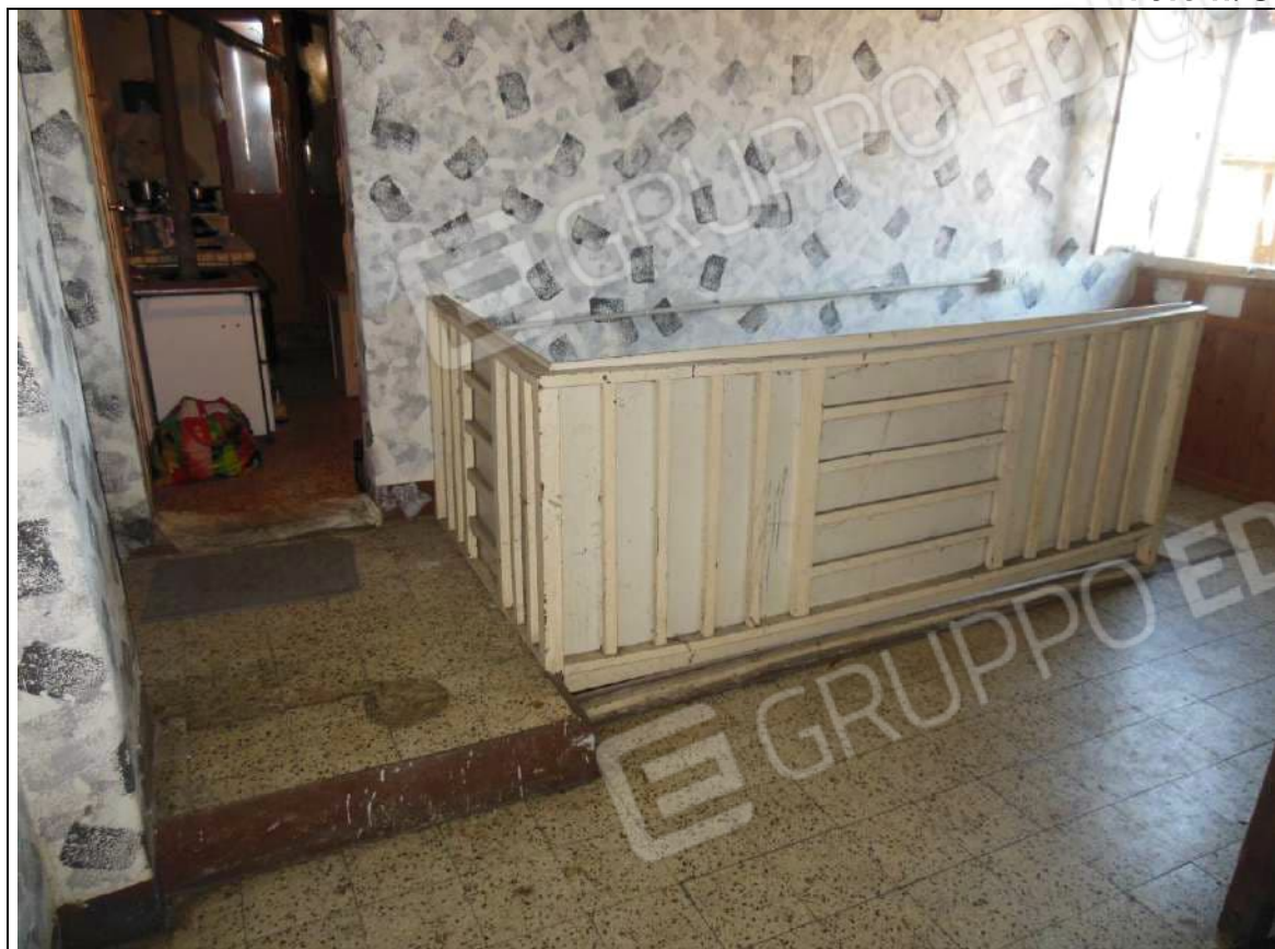
INTERNO ABITAZIONE MAPP. 21 SUB 1
