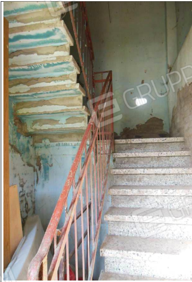
INTERNO ABITAZIONE MAPP. 21 SUB 2
