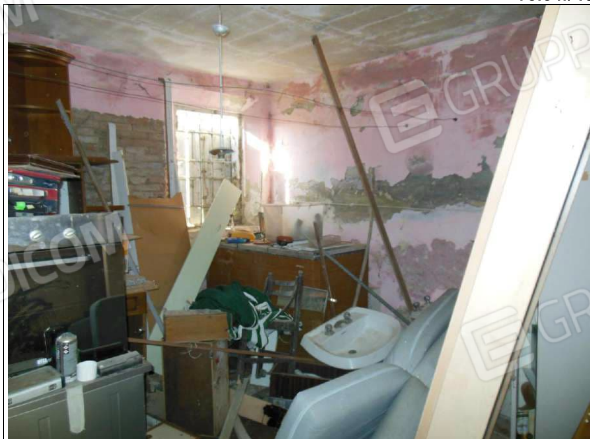
INTERNO ABITAZIONE MAPP. 21 SUB 2
