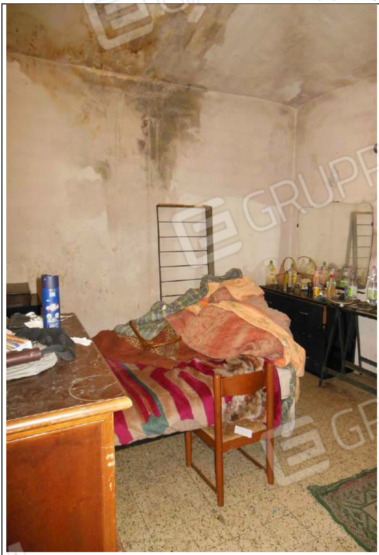
INTERNO ABITAZIONE MAPP. 21 SUB 1
