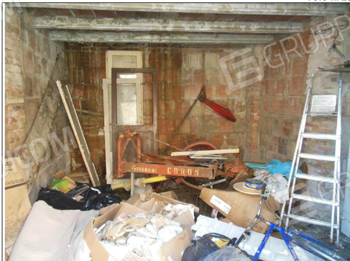
MAGAZZINO-PROSERVIZIO MAPP. 21 SUB 3
