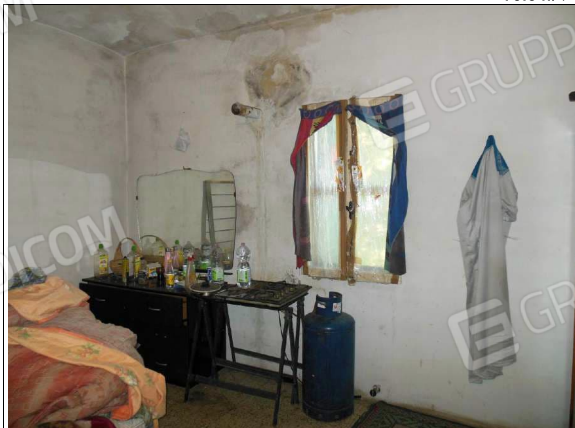
INTERNO ABITAZIONE MAPP. 21 SUB 1
