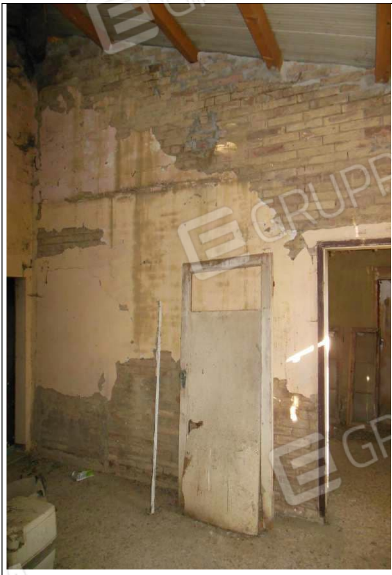
INTERNO ABITAZIONE MAPP. 21 SUB 2
