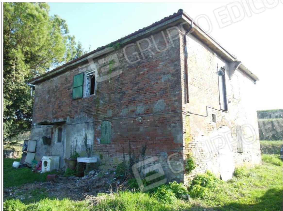
PROSPETTO LATERALE-POSTERIORE DEL FABBRICATO ABITATIVO
