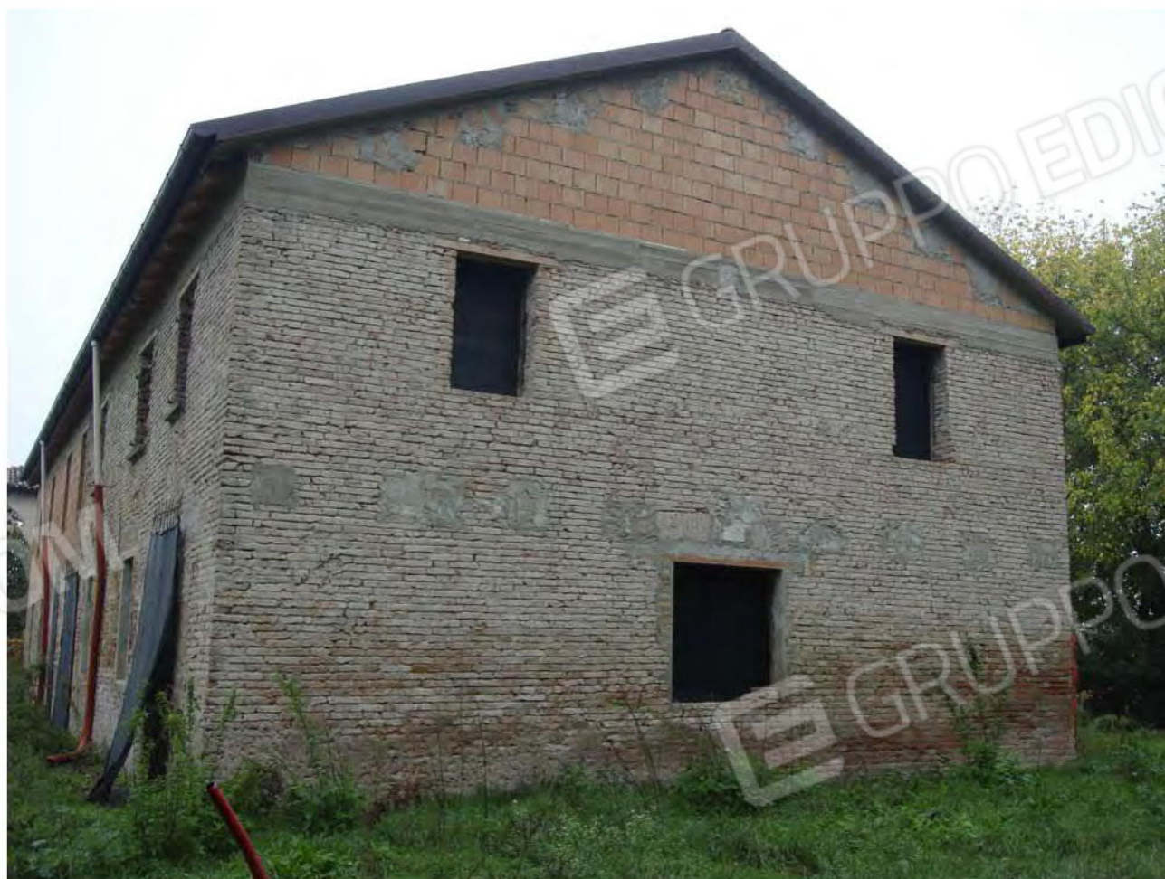
Foto 24. Mapp. 119. Prospetto Sud-Ovest.
