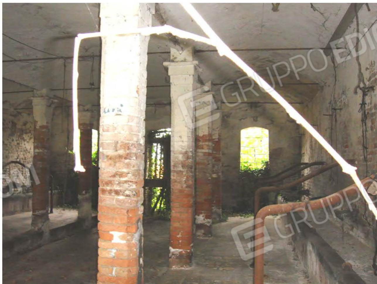
Foto 34. Mapp. 143 (ex mapp. 118). Particolare degli interni.
