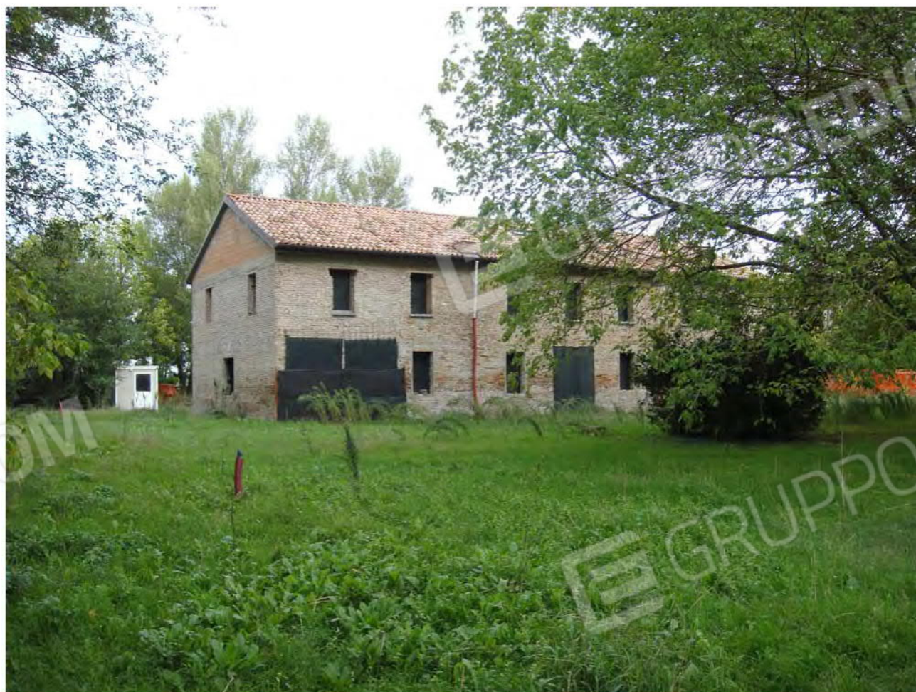
Foto 21. Mapp. 119. Prospetto Sud-Est e prospetto Sud-Ovest.
