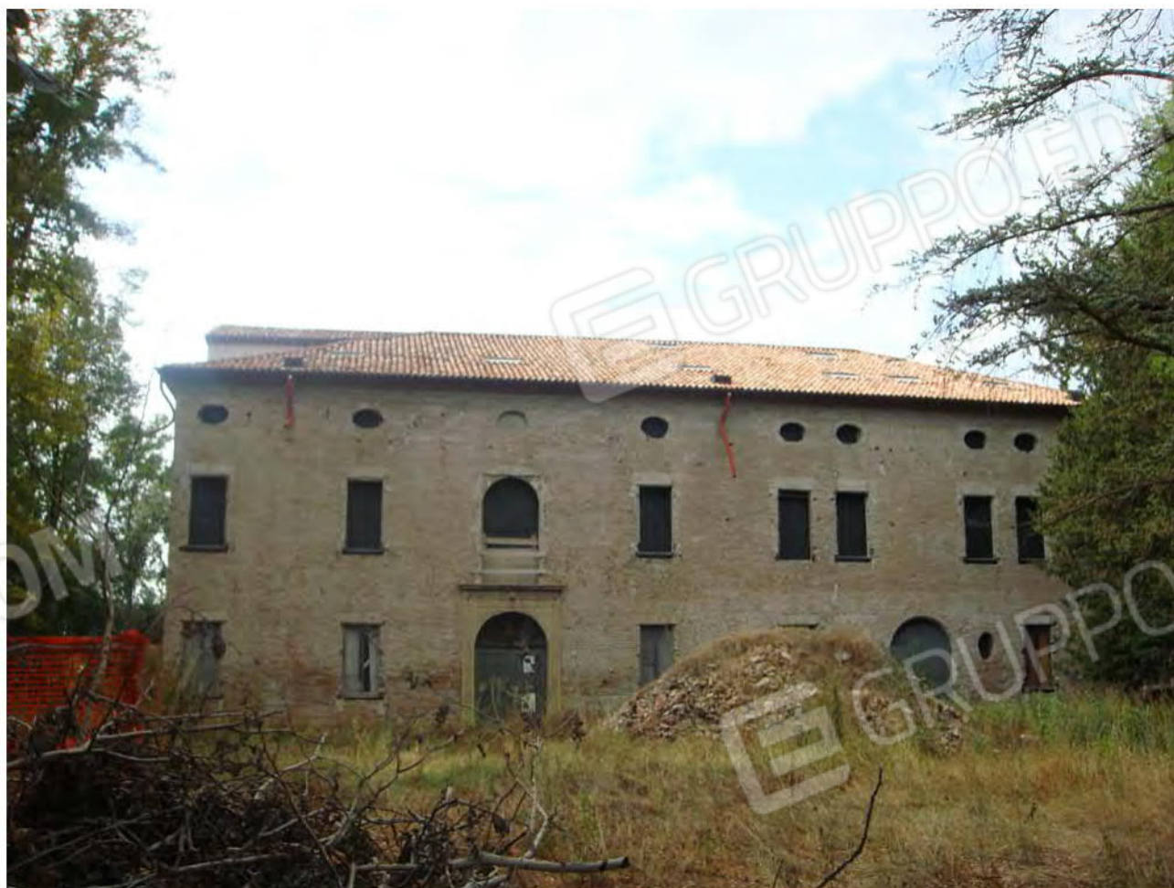
Foto 6. Mapp. 23. Prospetto Sud-Est.
