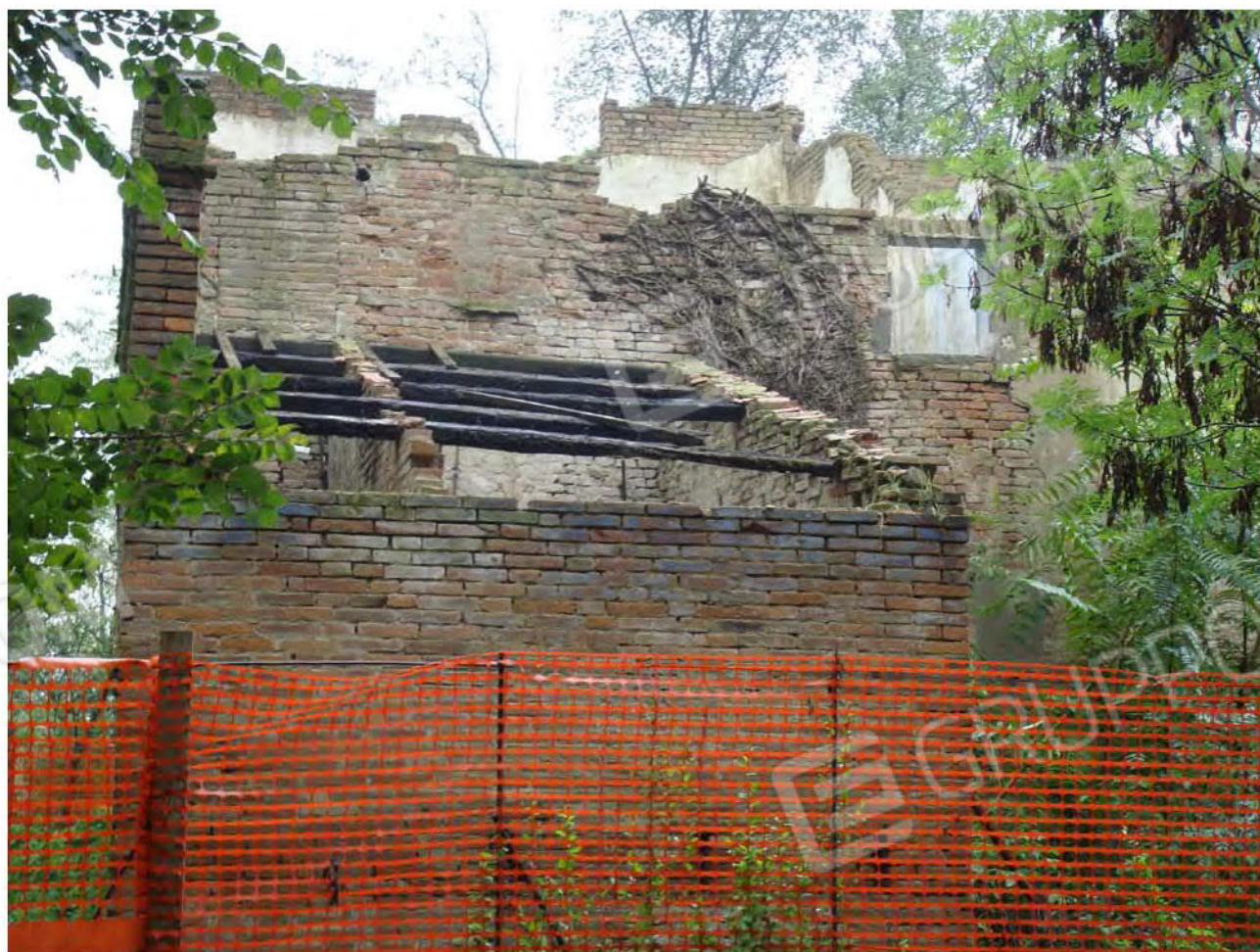
Foto 17. Mapp. 142 (ex mapp. 22). Parte del prospetto Nord-Ovest.
