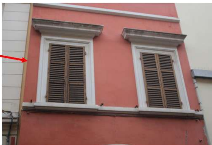
Foto 2b: dettaglio affaccio dell'unità pignorata su via delle Torri
