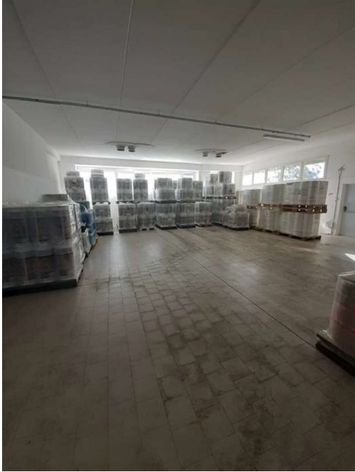
FOTO – capannone p.t.
