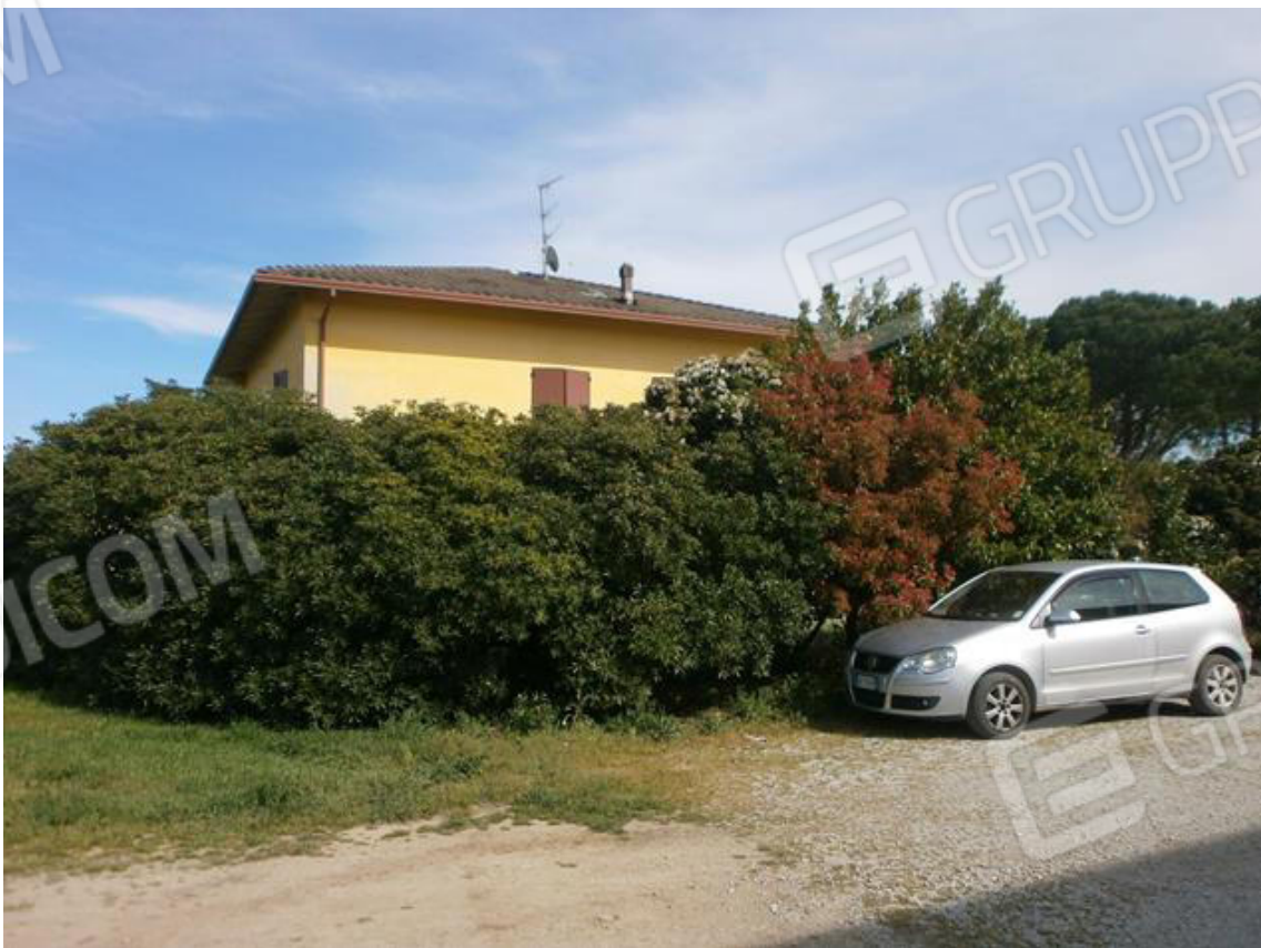
FOTO 2. Il fronte ovest del fabbricato bifamiliare con il giardino comune.
