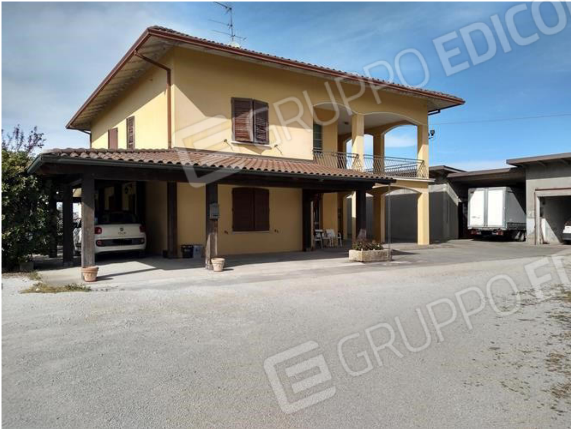
FOTO 1. Il fronte principale del fabbricato bifamiliare e il portico di accesso all'abitazione pignorata
