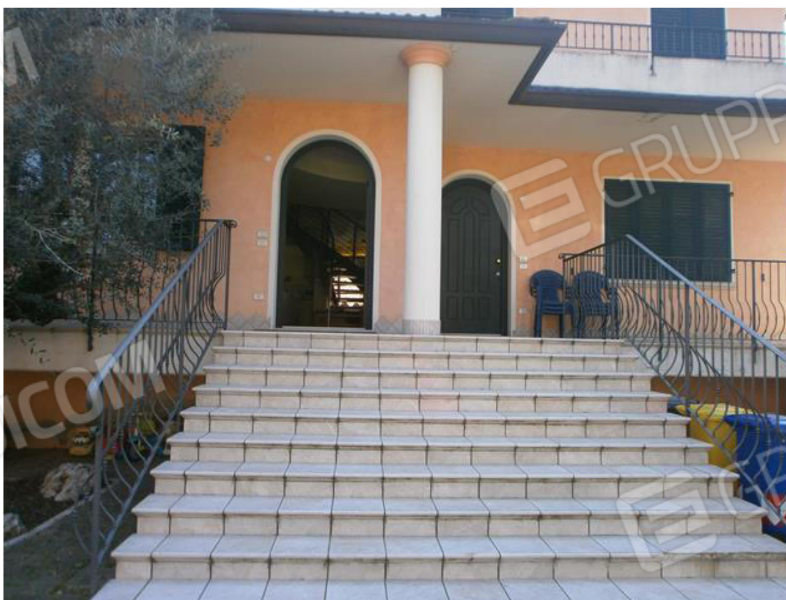
FOTO 7. Fabbricato bifamiliare: scala d'accesso agli ingressi delle due abitazioni (LOTTO UNO a sinistra)
