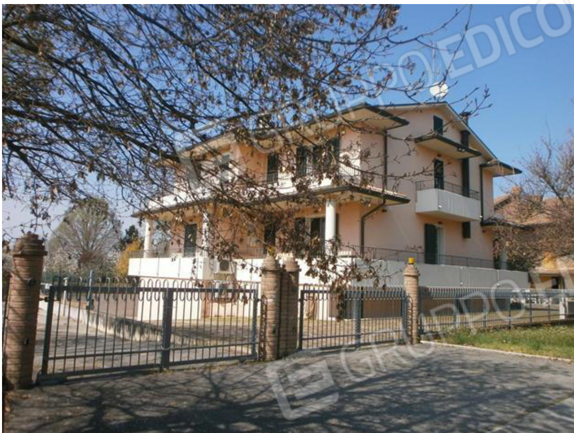
FOTO 3. Fabbricato bifamiliare: prospetto laterale e retro
