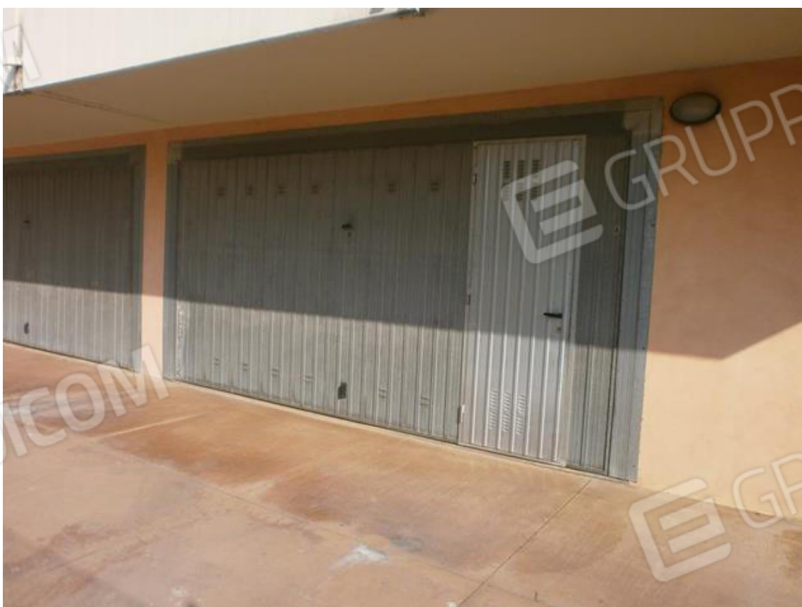
FOTO 29. Garage di pertinenza del LOTTO UNO: portone basculante di accesso
