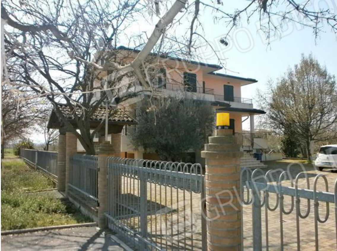
FOTO 1. Vista del fabbricato bifamiliare dalla Via Fernanda Viroli
