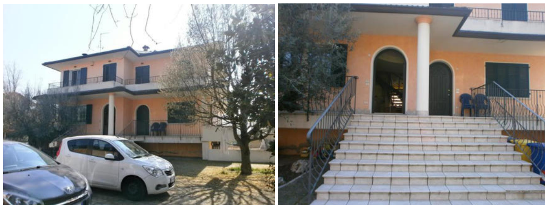
Il prospetto principale e la scala di accesso alle abitazioni (ingresso LOTTO DUE a sinistra)
