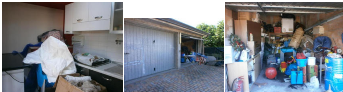
Lavanderia con cucina di servizio; il fabbricato di servizio con il garage e vista del suo interno
