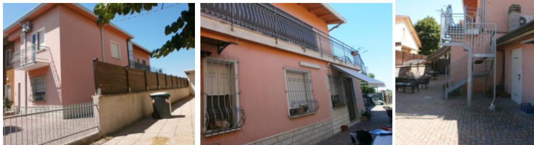
L'abitazione vista dalla strada (porzione sul retro) e dal cortile interno; scala esterna in metallo
