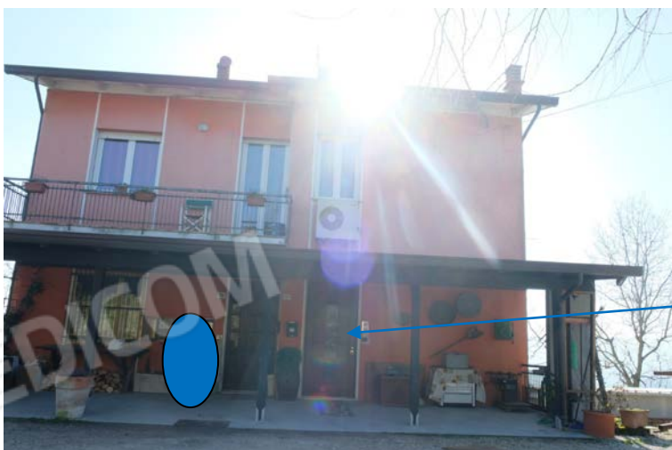
foto n.20 - veduta frontale del fabbricato ove sono ubicate le u.i. oggetto di procedura
