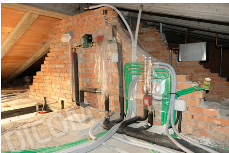
foto n.72 – veduta del sottotetto
