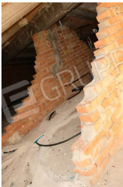
foto n.73-74 – veduta del sottotetto
