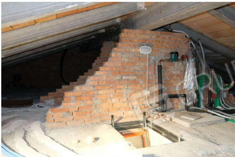
foto n.70 – veduta del sottotetto
