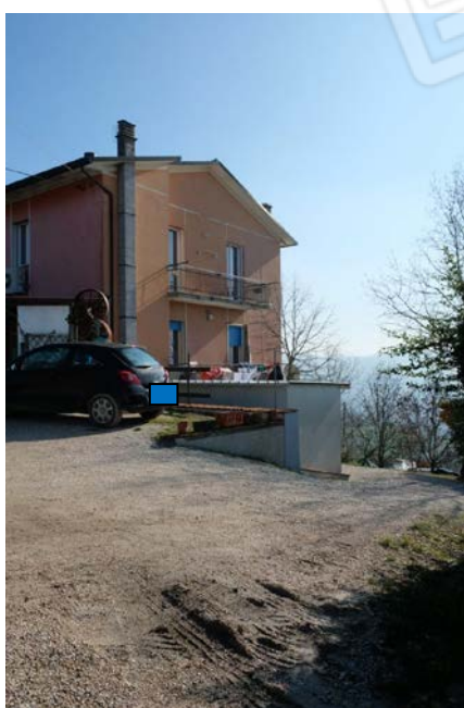
foto n.16-17 - veduta del retro del ripostiglio identificato con il sub.9 (bene comune non censibile), di parte della corte comune alle unità oggetto di procedura, anch'essa identificata con il sub.9 e di parte della corte comune a tutte le unità insistenti sulla particella 138, identificata con il sub.10.
