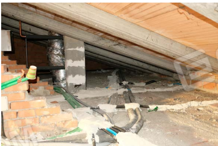
foto n.71 – veduta del sottotetto
