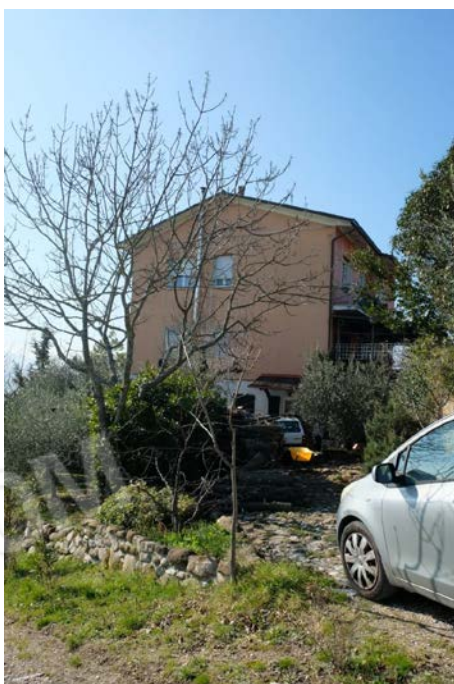
foto n.3 - veduta di parte dell'intero fabbricato in cui sono ubicate le u.i. oggetto di procedura, dallo stradello di accesso alla particella 138
