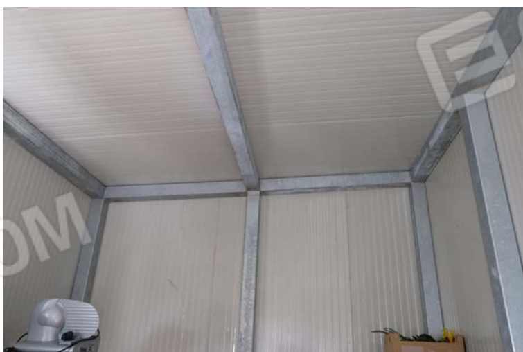
foto n.98 – particolare della struttura interna del ripostiglio di uso comune alle unità oggetto di procedura
