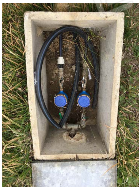
foto n.122-123 – veduta del pozzetto e dei contatori dell'acqua
