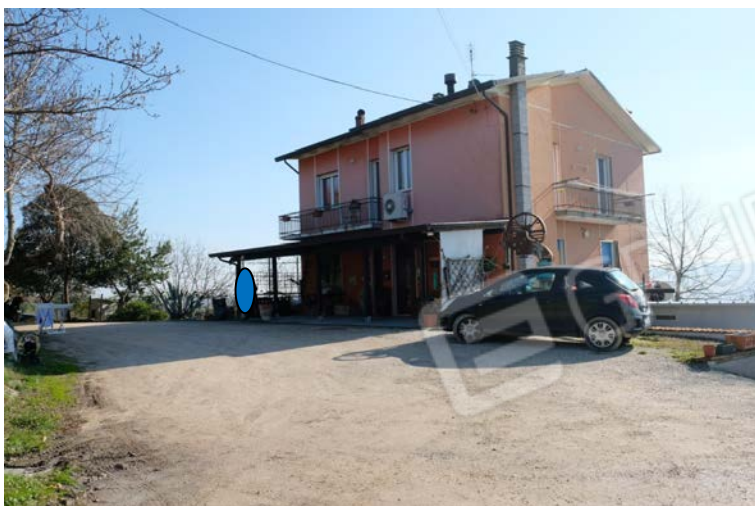
foto n.18 - veduta del fabbricato ove sono ubicate le u.i. oggetto di procedura e di parte della corte comune a tutte le unità insistenti sulla particella 138, identificata con il sub.10.
