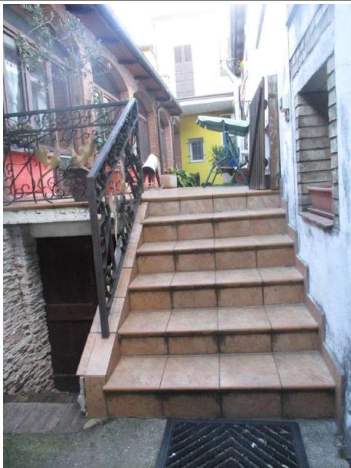
Scala esterna per accedere al livello del sub.14
