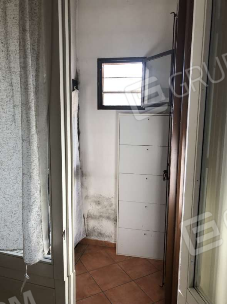
Foto 13- disimpegno alle particelle 1032 e 1033
