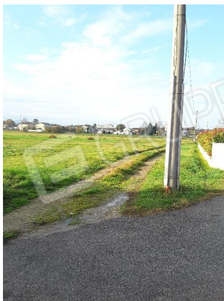
Vista di un palo in cemento per l'energia elettrica in corrispondenza della strada (via Susa) in confine al terreno
