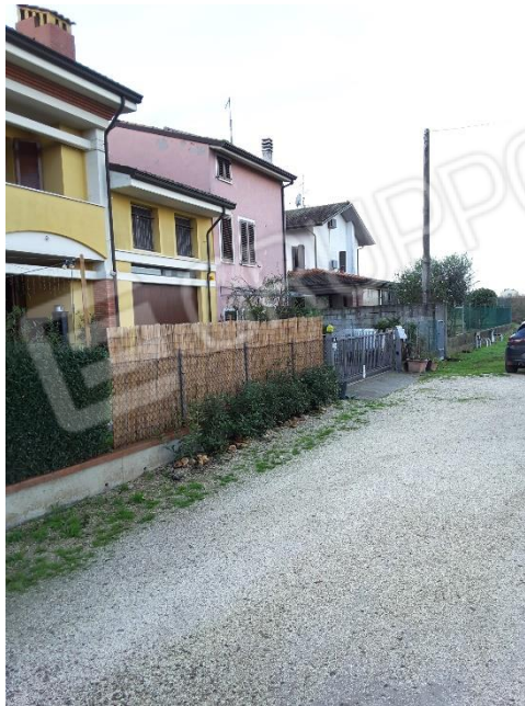
Vista delimitazioni del terreno sul lato in confine con le proprietà particelle 75, 74, 301 e 793
