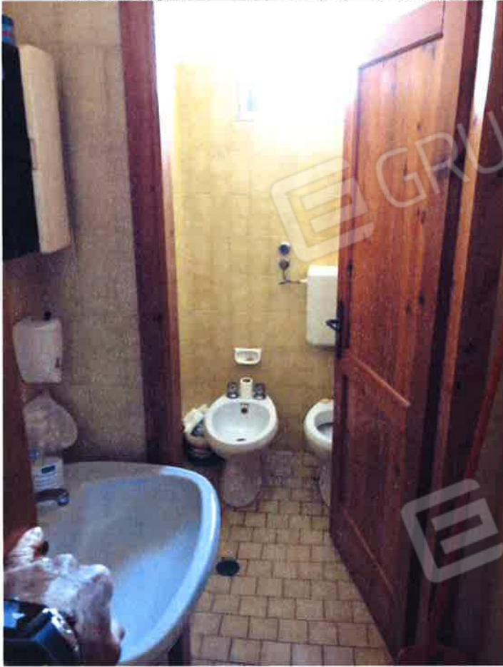
Foto 27- bagno di servizio alla cucina
