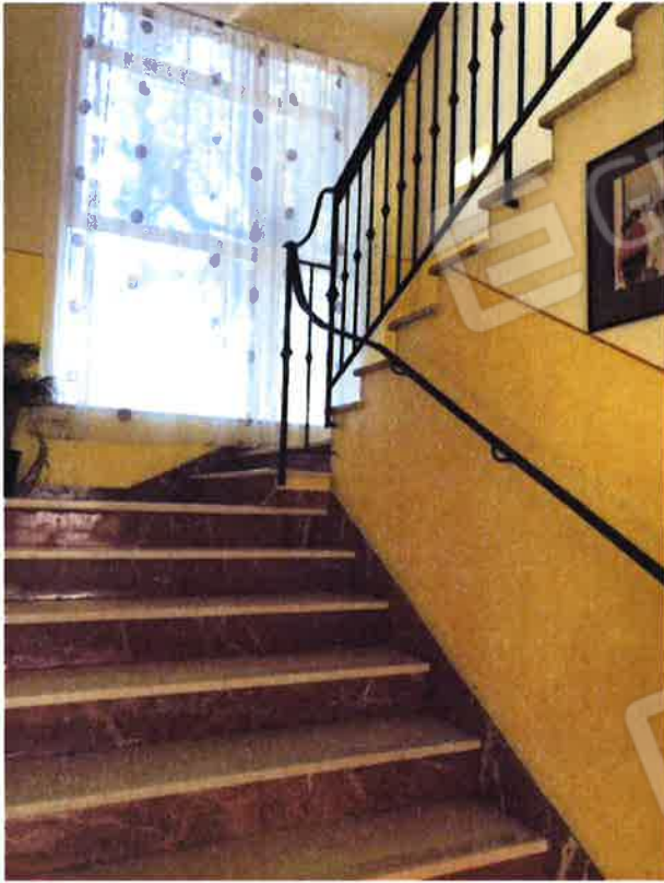
Foto 23- Vano scala al 1° piano
