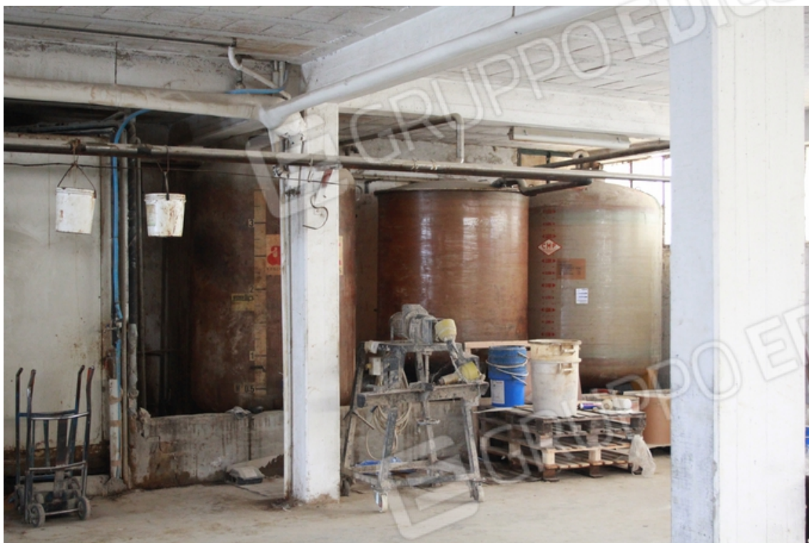
capannone/mangimificio piano terra
