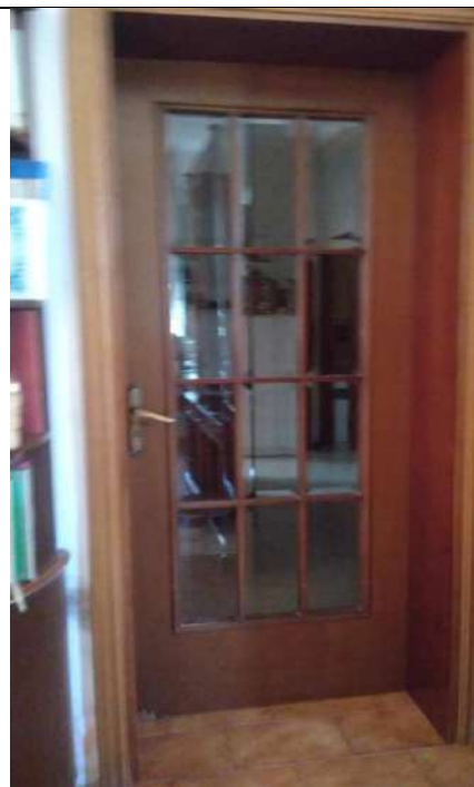
Particolare infisso interno
