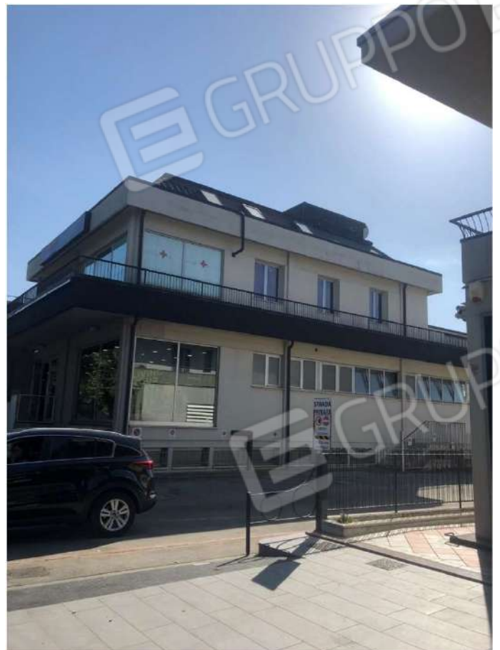
Foto 2 - Prospetto Nord-Ovest – Viale Roma
