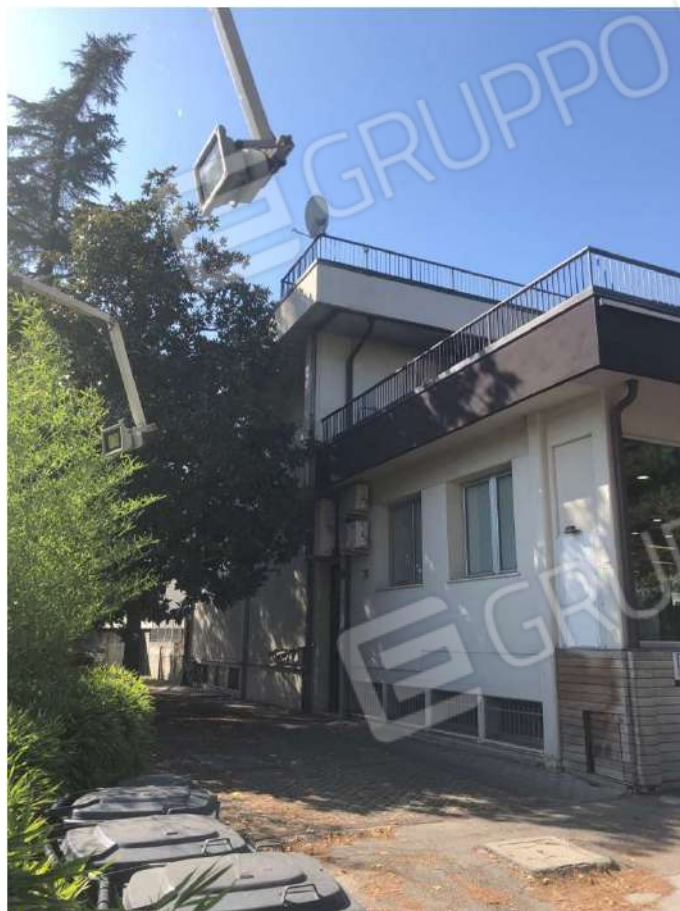
Foto 4 - Prospetto Sud-Ovest – Viale Roma
