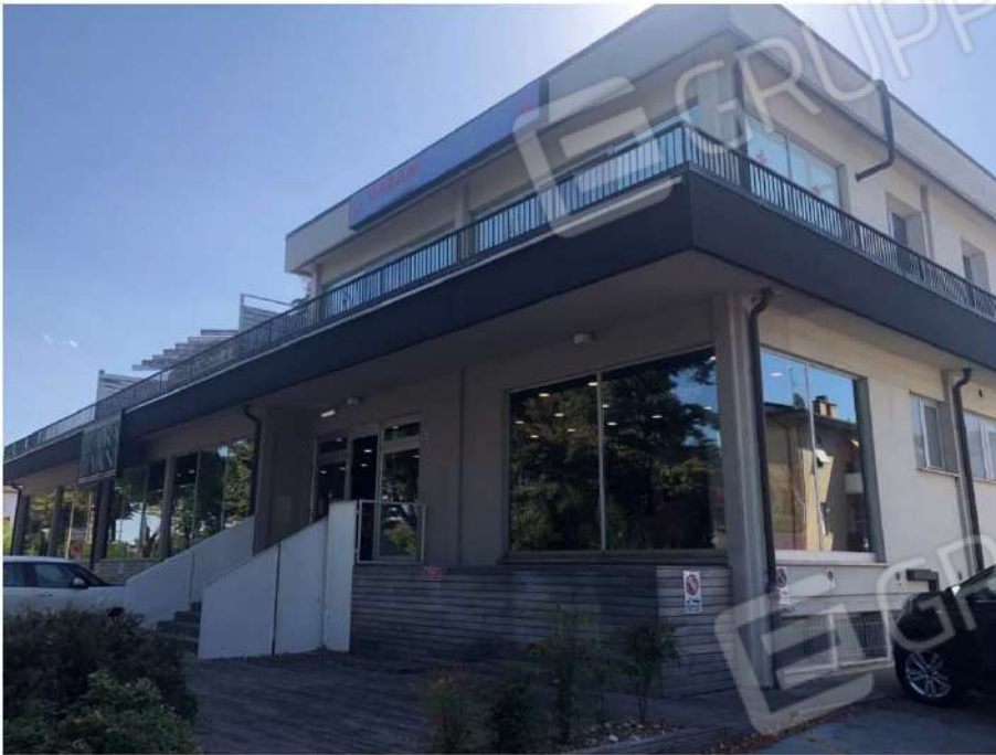
Foto 1 - Prospetto Nord-Est – Viale Roma
