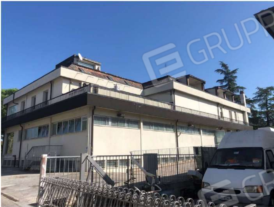
Foto 3 - Prospetto Sud-Ovest – Viale Roma
