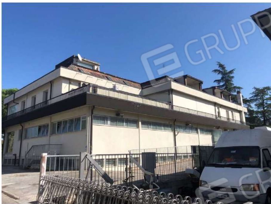
Foto 3 - Prospetto Sud-Ovest – Viale Roma
