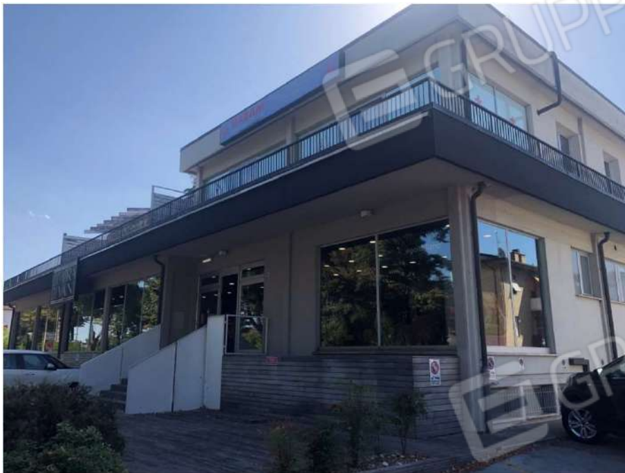
Foto 1 - Prospetto Nord-Est – Viale Roma
