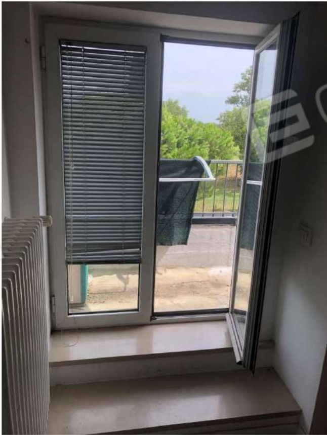
Foto 17 – accesso al terrazzo
