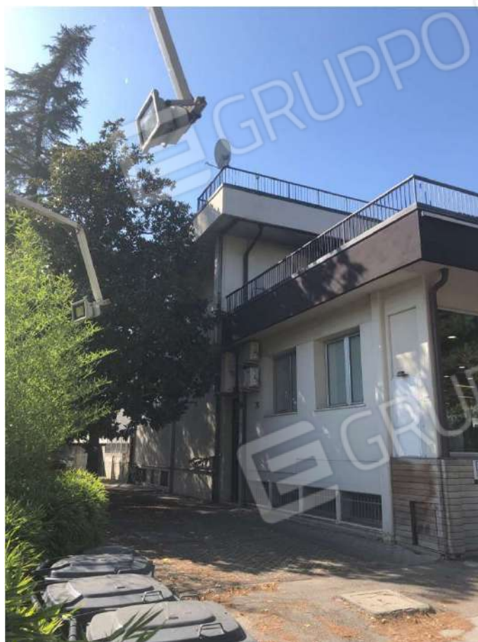
Foto 4 - Prospetto Sud-Ovest – Viale Roma
