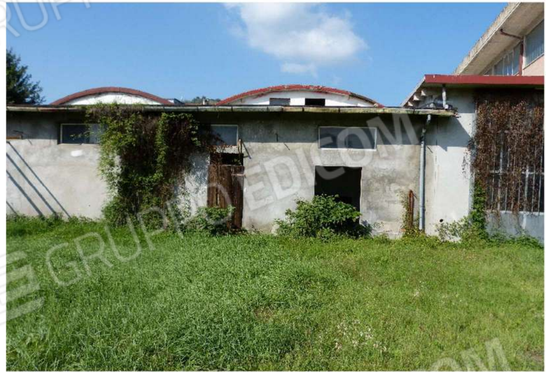
vista esterna lato sud ovest - locale "laboratorio"
