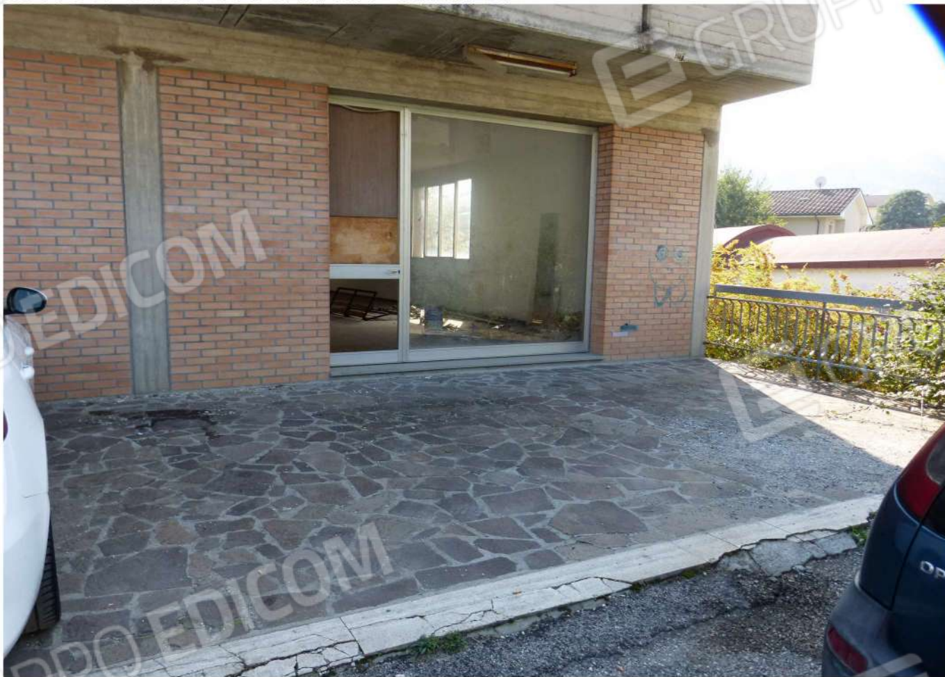
ingresso area espositiva - piano terra
