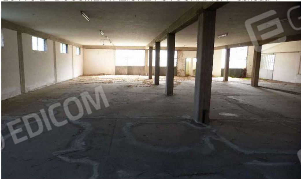
locale ad uso deposito - corpo principale
