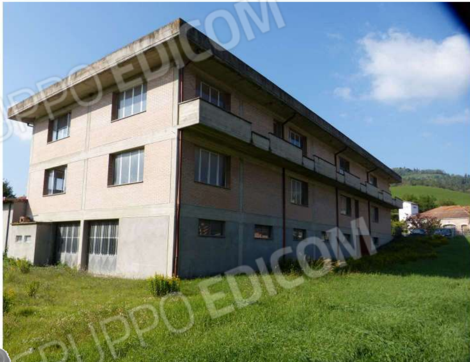
vista compressiva del fabbricato principale
