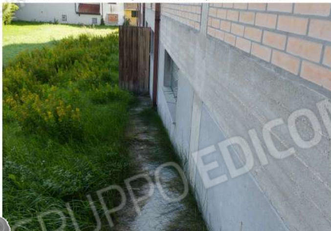
vista parte basamentale
