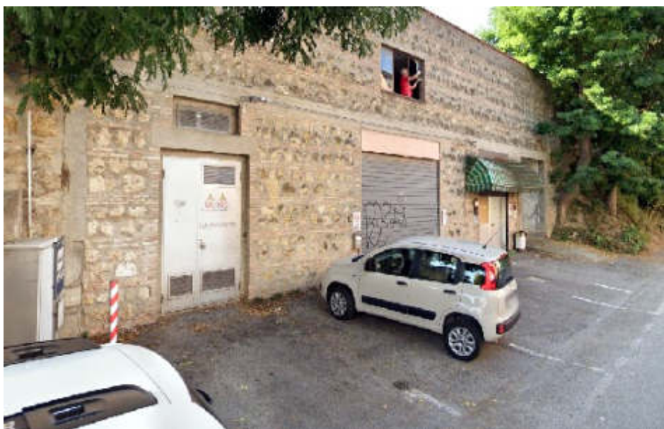
Fronte su via Giovanni Bovio n.15
