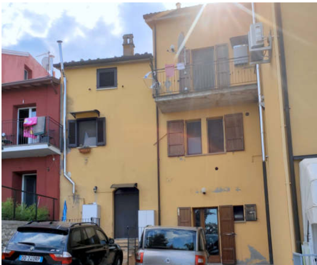
Accesso al piano interrato
