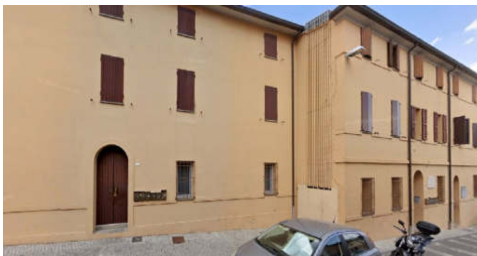
Fronte su via Cavour nn.5-7
