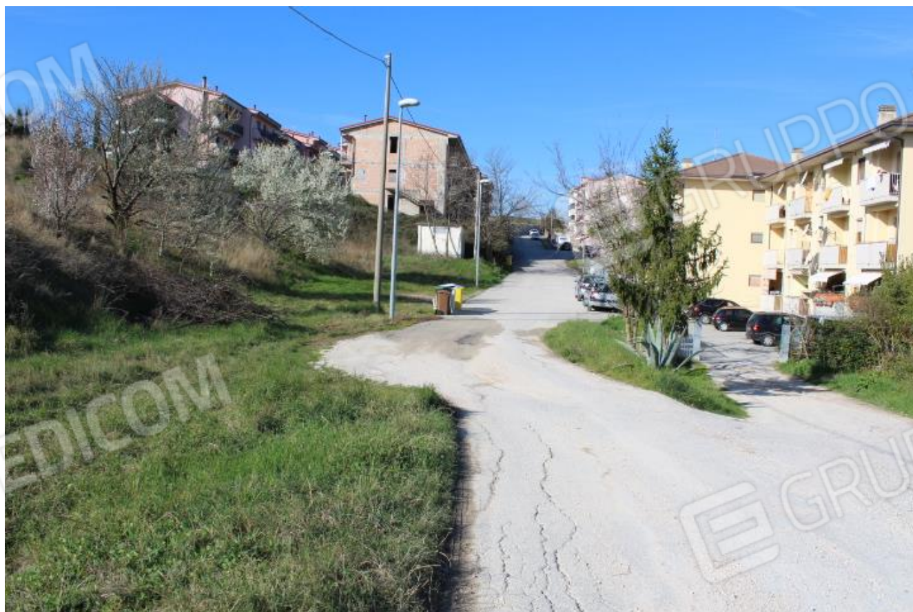
FOTO 26 – VISTA DELLA STRADA VERSO OVEST
