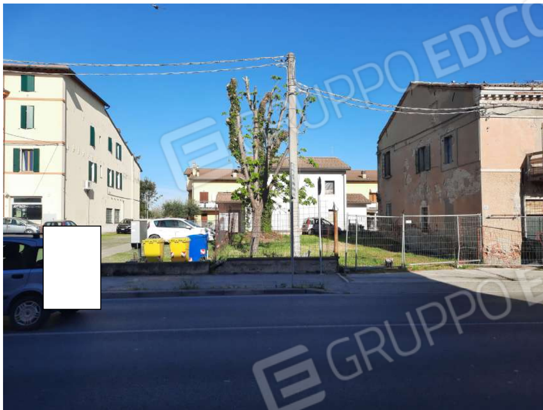
2 - VISTA GENERALE DA VIA LUGHESE
