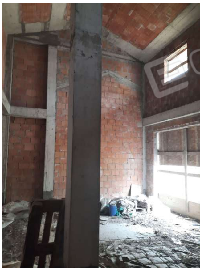
17 – VISTA PROSERVIZIO - INTERNO
