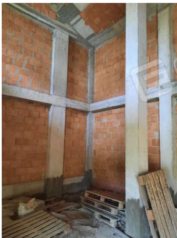
15 – VISTA PROSERVIZIO - INTERNO
