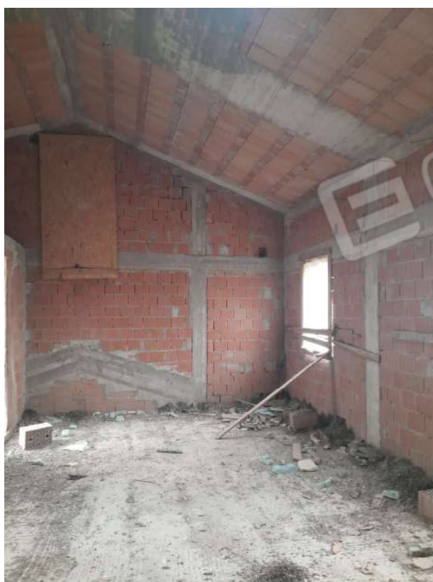
13 – VISTA PIANO PRIMO
