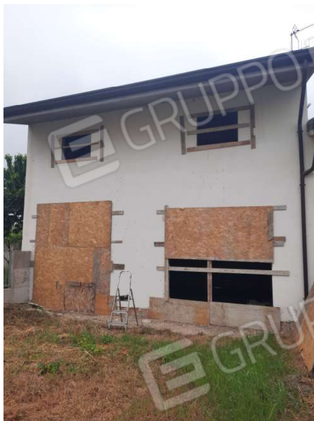
14 – VISTA FRONTE - PROSERVIZIO
