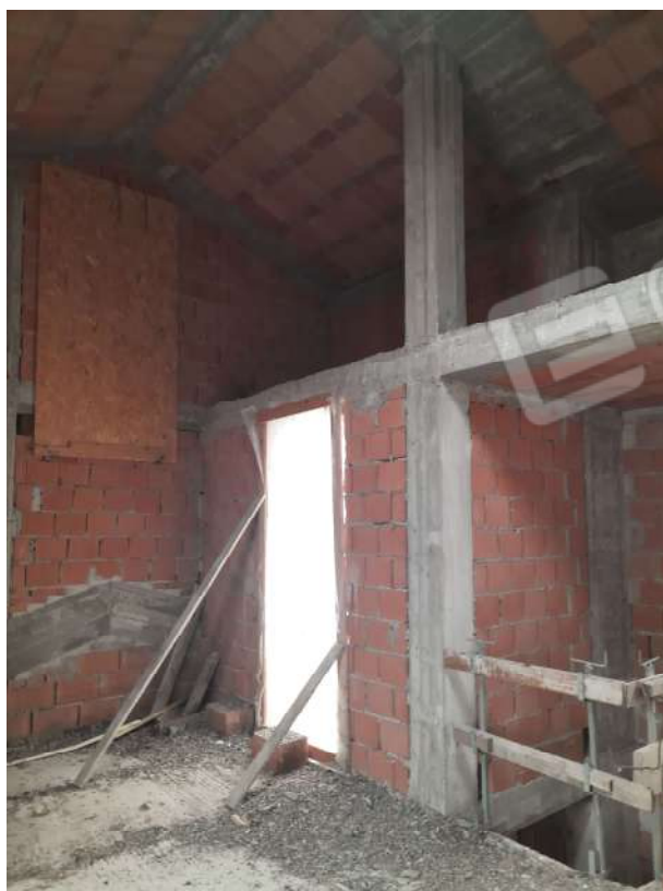
11 – VISTA PIANO PRIMO
