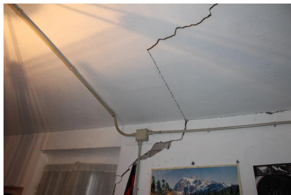
PARTICOLARE LESIONE STRUTTURALE NELLA CAMERA DA LETTO 1
