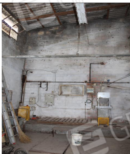
VANO SERVIZIO CON IMPIANTI E PARTICOLARE COPERTURA IN ETERNIT
