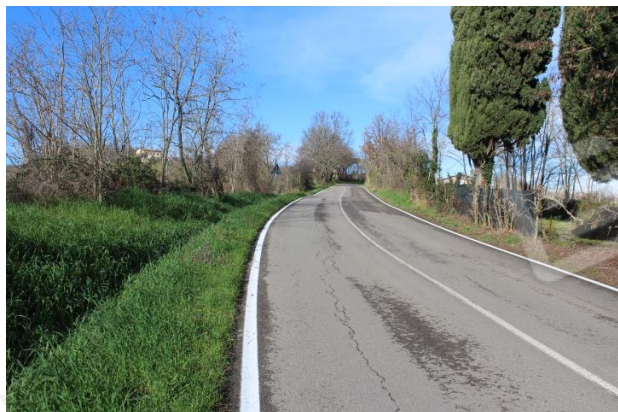
STRADA PUBBLICA IN DIREZIONE OVEST – ROCCA DELLE CAMINATE
