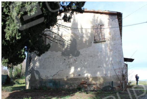
FABBRICATO COLLABENTE, PROSPETTO SUD FRONTE STRADA
