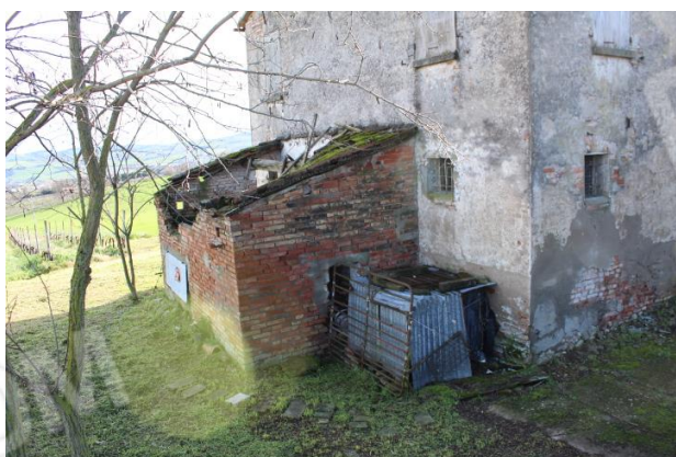
PARTICOLARE MANUFATTO ADIACENTE DI CUI NON E' NOTA LA DATA DI COSTRUZIONE
