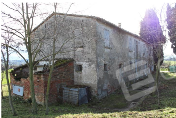
PROSPETTO NORD E LATO OVEST. PARTICOLARE MANUFATTO ADIACENTE DI CUI NON E' NOTA LA DATA DI COSTRUZIONE
