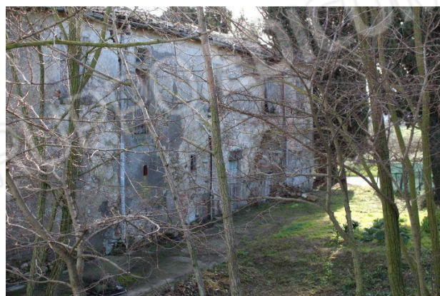
PARTICOLARE PROSPETTO OVEST CON PORZIONE DI MURATURA ESTERNA CROLLATA
