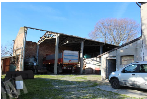
CORPO SERVIZI LATO OVEST, CON PARTE DELLA COPERTURA COLLATA
