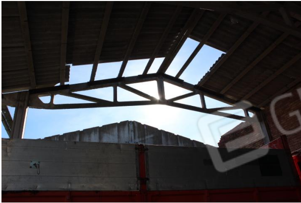
PARTICOLARE COPERTURA CROLLATA AL SERVIZIO AGRICOLO
