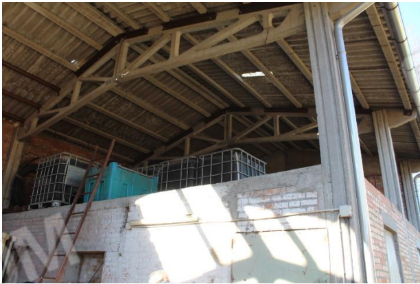
PARTICOLARE COPERTURA IN LASTRE DI ETERNIT
