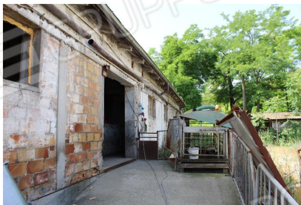
RAMPA DI ACCESSO
