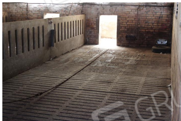
PARTICOLARE DEL PAVIMENTO GRIGLIATO
