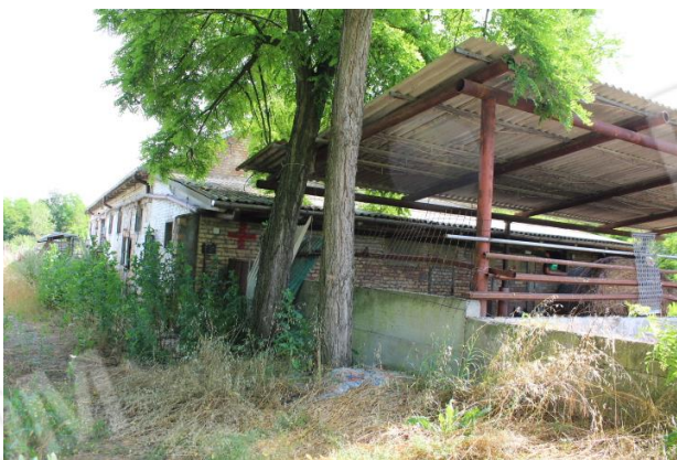
PROSPETTO OVEST E TETTOIA
