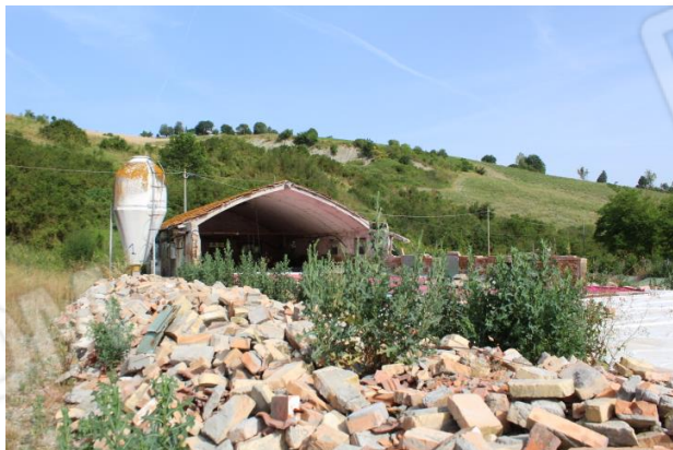
ALLEVAMENTO IN PARTE CROLLATO; PARTICOLARE MACERIE DA SMALTIRE IN DISCARICA AUTORIZZATA
