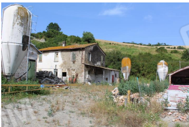
VISTA DALLA STRADA DEI TRE SILOS INSTALLATI
