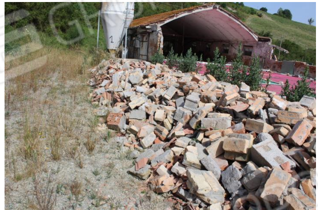
PARTICOLARE MACERIE ALLEVAMENTO CROLLATO
