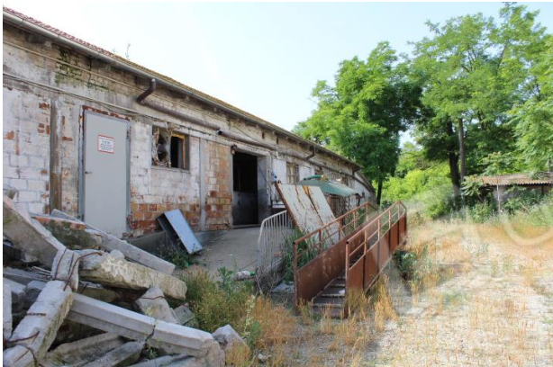
PROSPETTO OVEST; RAMPA DI ACCESSO ALL'ALLEVAMENTO SUINI
