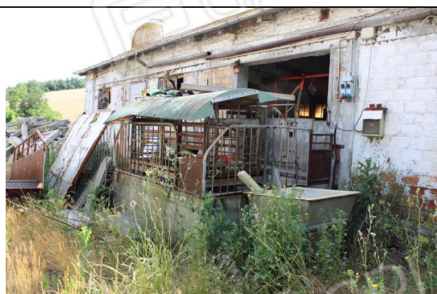
PARTICOLARE SUL PROSPETTO OVEST, DELL'ACCESSO ALL'ALLEVAMENTO RIALZATO DA RAMPA ESTERNA
