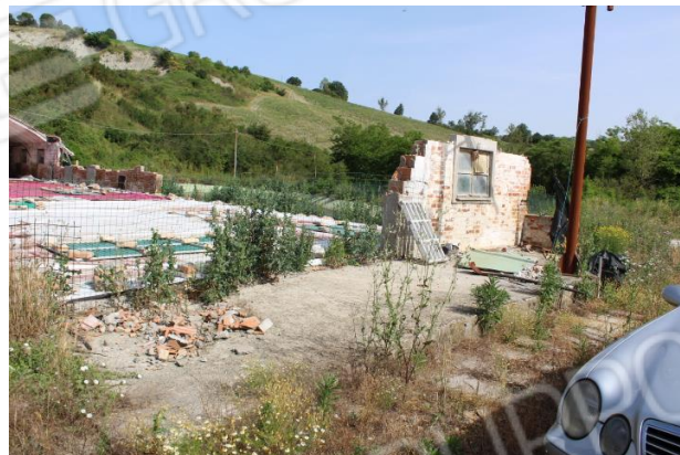
ALLEVAMENTO IN PARTE CROLLATO
