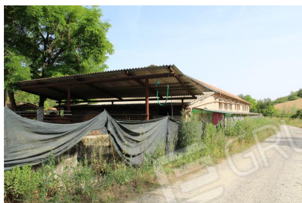
TETTOIA E PROSPETTO LATO STRADA DELL'ALLEVAMENTO
