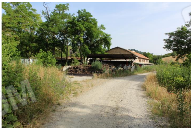
ALLEVAMENTO SUINI VISTO DA SUD VERSO NORD E STRADA PUBBLICA
