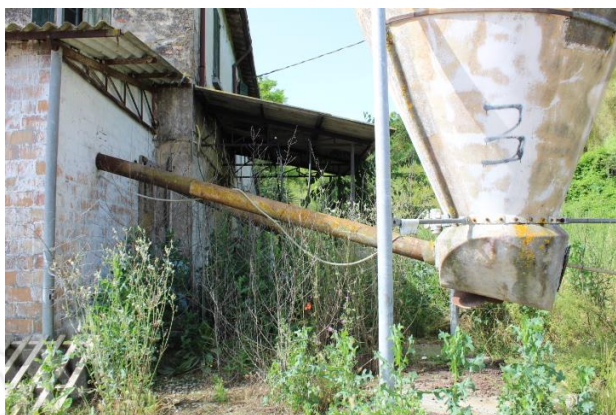
SILOS POSTO A LATO DEL VANO DEPOSITO ADIACENTE ALL'ABITAZIONE COLONICA
