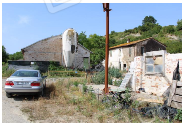
VISTA DALLA STRADA, DEI CORPI DI FABBRICA ESISTENTI (allevamento corpo 1, abitazione colonica, allevamento corpo 2 crollato)
