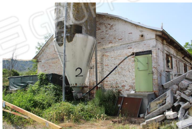
PARTICOLARE SILOS ALLEVAMENTO CORPO 1
