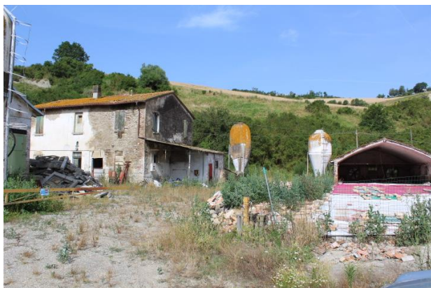
CASA COLONICA E DI LATO L'ALLEVAMENTO CORPO 2, CROLLATO
