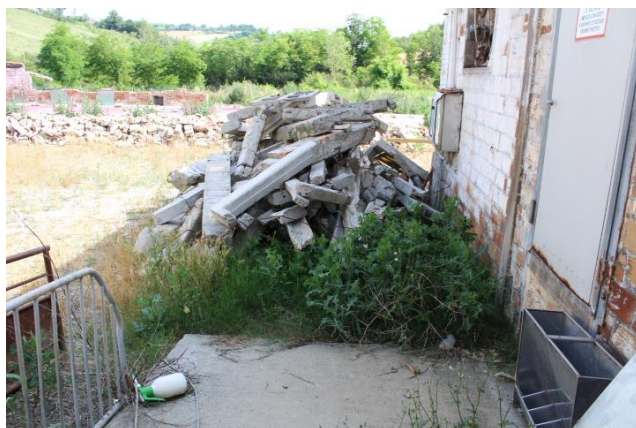
CUMULO DI MACERIE DI LATO ALL'ALLEVAMENTO CORPO 2, DA SMALTIRE IN DISCARICA AUTOTIZZATA
