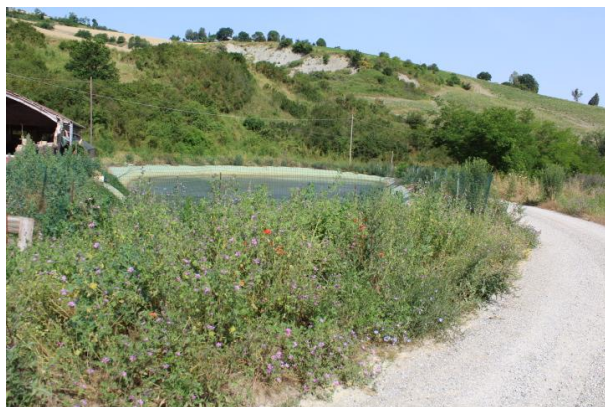
PARTICOLARE CONCIMAIA CON PERCOLATO STAGNANTE, NON COLLEGATA AL BACINO STOCCAGGIO DI LIQUAMI
