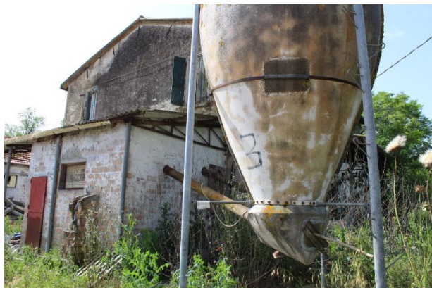
CASA COLONICA, PROSPETTO NORD E PARTICOLARE SILOS
