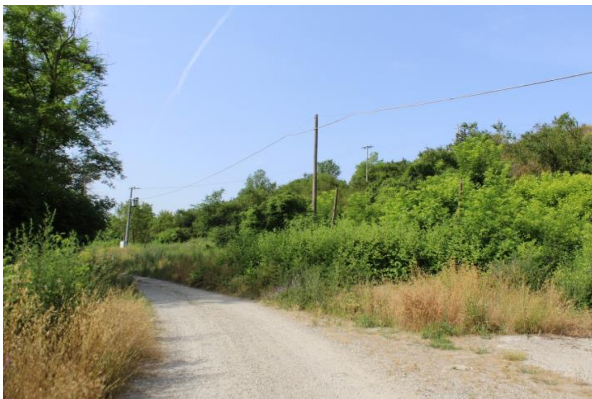
PARTICOLARE DELLE DUE LINEE ELETTRICHE (una in attraversamento ed una parallela alla strada pubblica)
