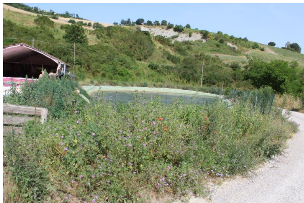
LAGONE DI STOCCAGGIO LIQUAMI (in parte realizzato al di fuori della proprietà; su terreno demaniale)
