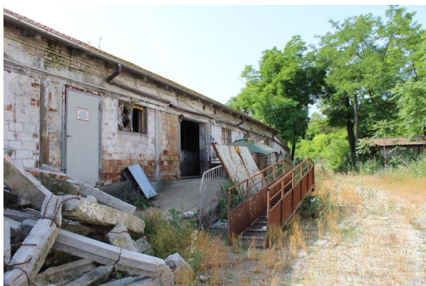
INGRESSO ALL'ALLEVAMENTO CORPO 1, MEDIANTE RAMPA
