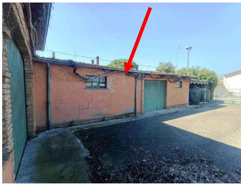
VISTA DEGLI ESTERNI DEL CORPO -A1- CON COPERTURA IN ALSTRE DI “ETERNIT”
