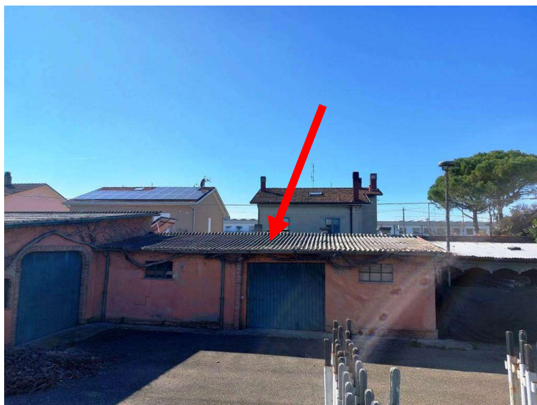
VISTA DEGLI ESTERNI DEL CORPO -A1- CON COPERTURA IN ALSTRE DI “ETERNIT”
