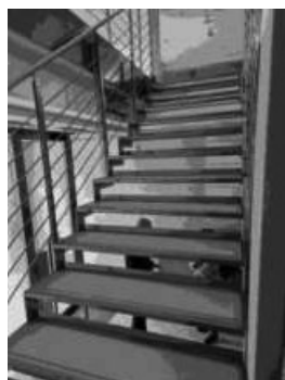
La scala, in vetro e acciaio, di accesso al piano primo del negozio
