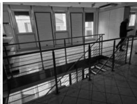
La scala, in vetro e acciaio, di accesso al piano primo del negozio
