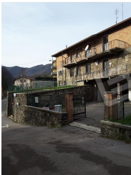
Vista su via Del Faggio della recinzione, interrotta da un cancello in ferro a due ante posto a filo della recinzione e sorretto da due colonne in mattoni faccia vista
