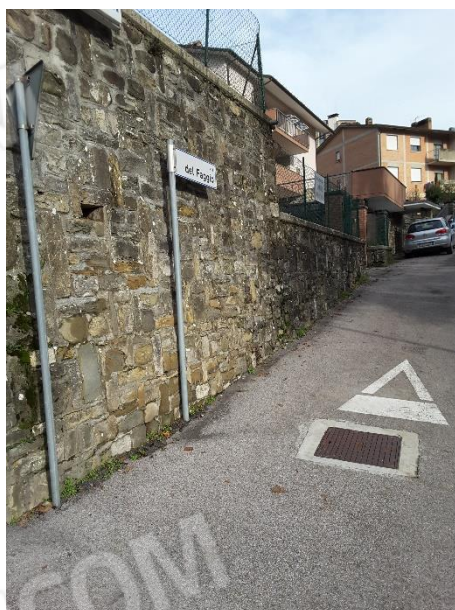
Vista della proprietà delimitata dalle due strade (via dell'Orto via del Faggio) per mezzo di un muro in muratura e sasso a vista, di varia altezza poichè segue l'andamento naturale del terreno, e sovrastante rete metallica plastificata sorretta da paletti in ferro
