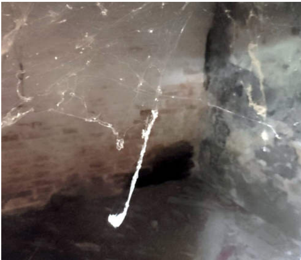
Cantina al piano interrato
