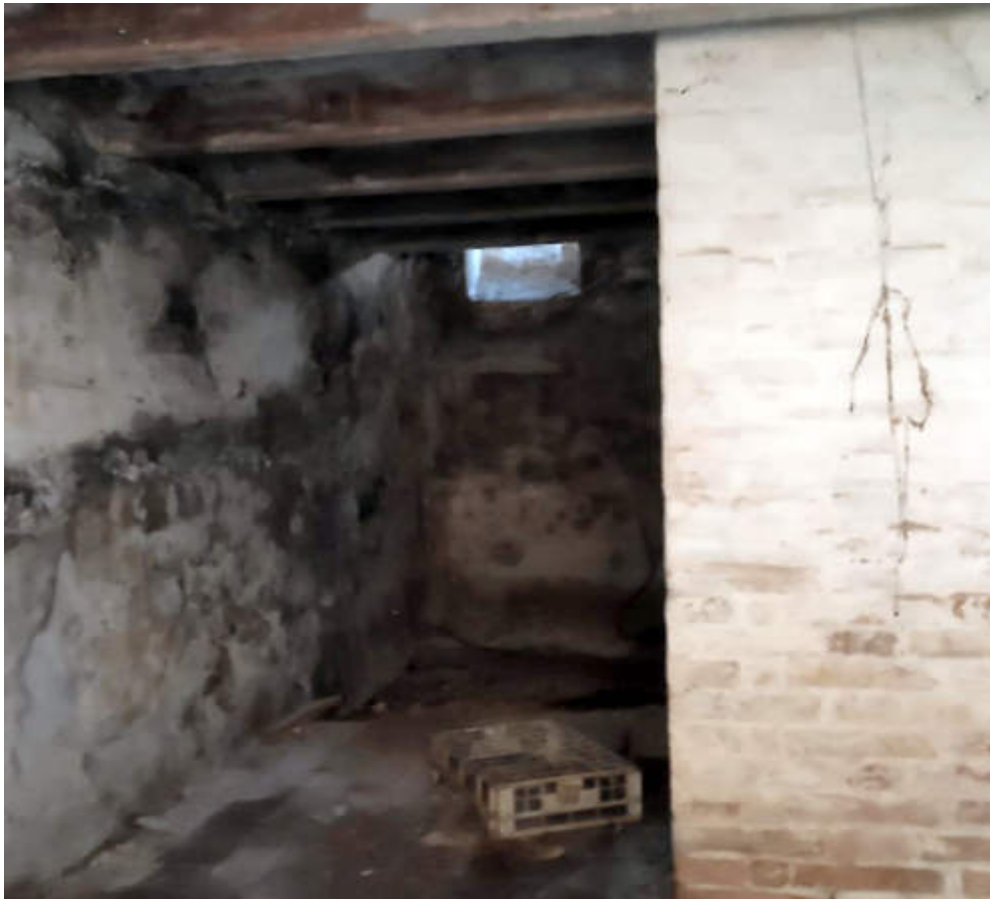
Cantina al piano interrato
