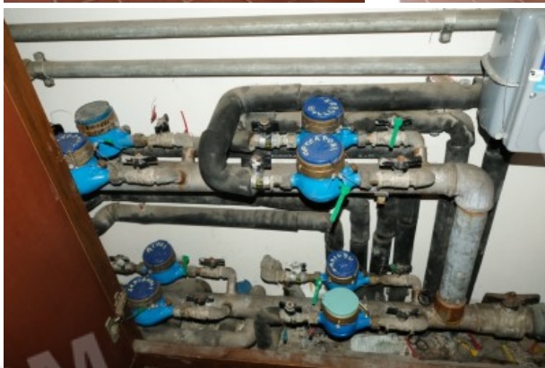
foto n.102-103-104 – vedute della nicchia dei contatori per la fornitura del gas e dell'acqua, ubicata in fondo al corridoio di ingresso al fabbricato dal civico 18 di via Chiaramonti, di cui al sub.38 dell'e.p.
