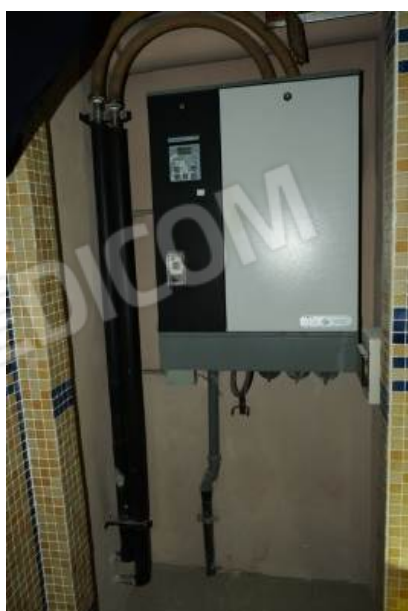
foto n.93-94 – particolari della “caldaia” ubicata al piano primo sottostrada presumibilmente per il funzionamento del bagno turco
