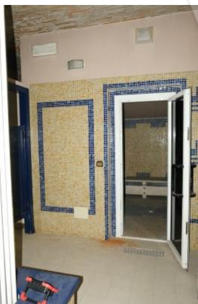
foto n.51-52 – vedute delle pareti divisorie realizzate in cartongesso e/o muratura nel “magazzino” al piano primo sottostrada al fine di realizzare vari ambienti ad uso “spa/centro benessere” quali bagno turco, idromassaggio, zona relax, docce
