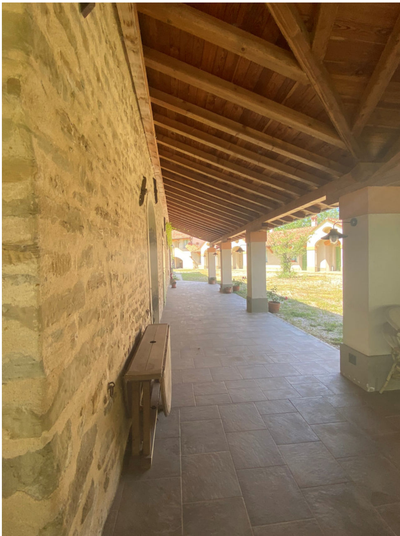
Fot. 08 - Dettaglio della tettoia in legno sulla parte posteriore dell'edificio ristorante/alloggi per ospiti.
