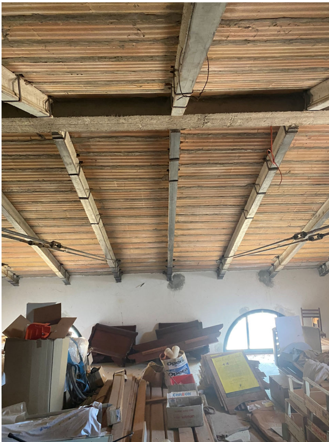
Fot. 16 - Vista dei locali destinati a ripostiglio nel sottotetto della sala convegni/workshop.
