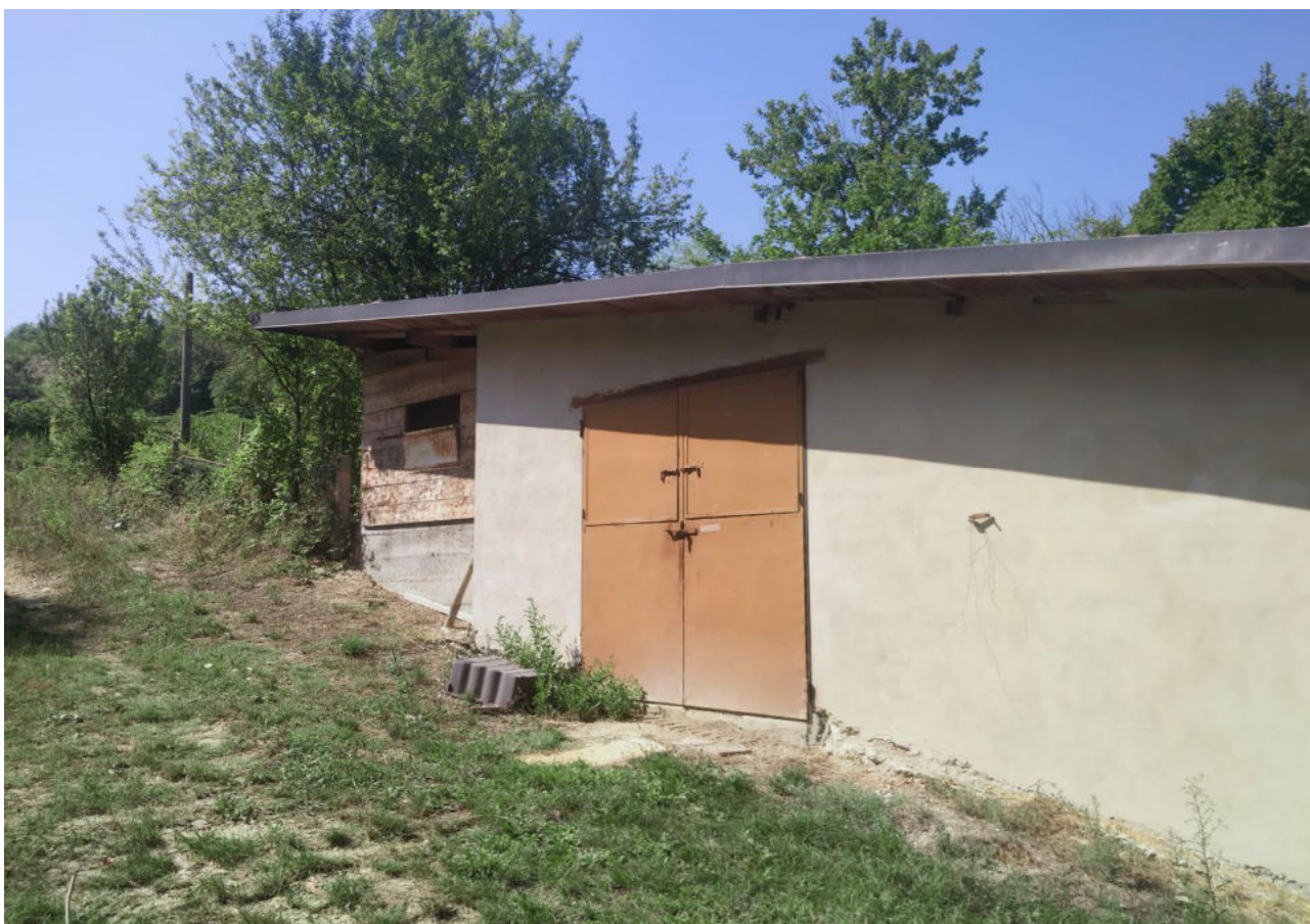
Fot. 3 - Vista del proservizio
