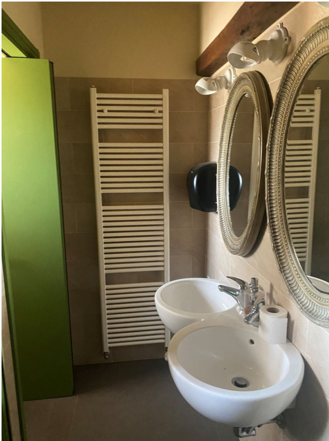
Fot. 20 - Vista dei dettagli interni delle unità destinate ad alloggi per ospiti.
