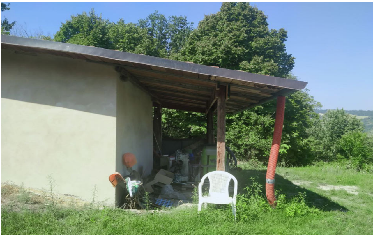
Fot. 2 - Vista della tettoia del proservizio.
