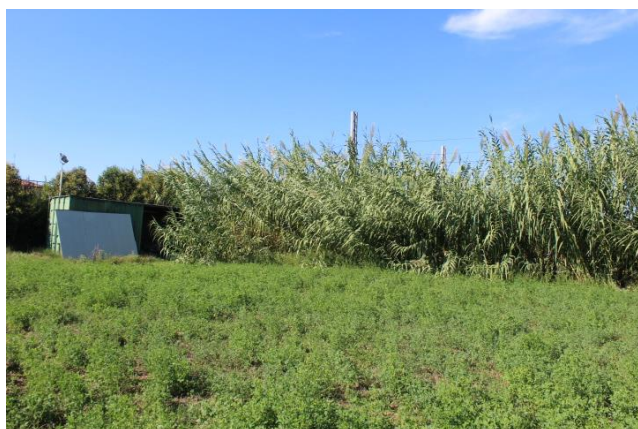
TERRENO AGRICOLO, CON CANNETO POSTO PARALLELO ALLA LINEA FERROVIARIA, CON MANUFATTO ABUSIVO DA RIMUOVERE INTEGRALMENTE
