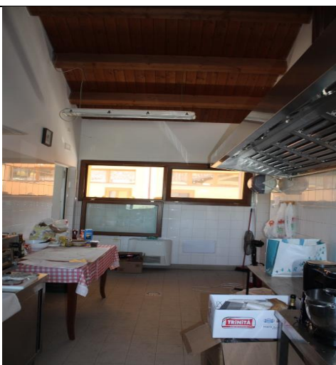
CUCINA DEL RISTORANTE CON PARTICOLARE DELLA COPERTURA IN LEGNO
