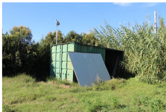
PARTICOLARE DEL MANUFATTO ABUSIVO DA RIMUOVERE INTEGRALMENTE
