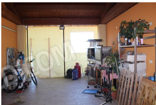
PORTICO DI COLLEGAMENTO AL RISTORANTE
