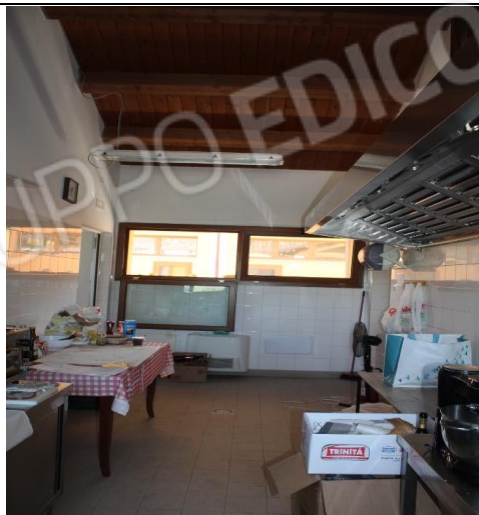
CUCINA CON VISTA DELLA COPERTURA IN LEGNO
