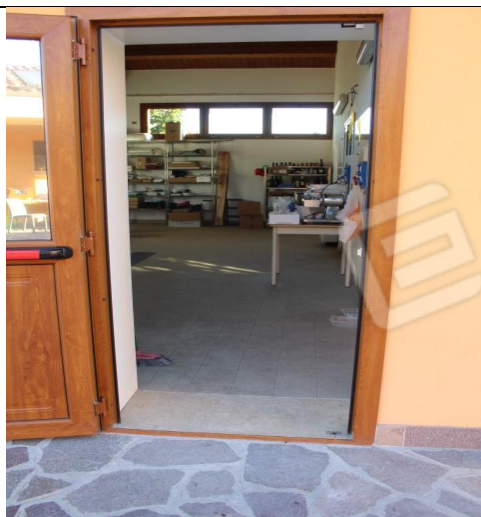
DALLA CORTE ACCESSO AL LABORATORIO
