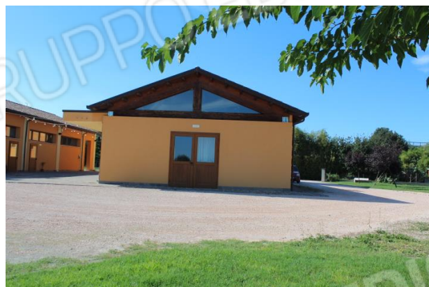
PARTICOLARE DEL RISTORANTE VISTO DA EST
