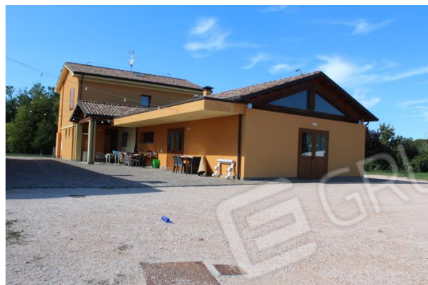
VISTA DA SUD-EST DEL RISTORANTE E DELL'ABITAZIONE
