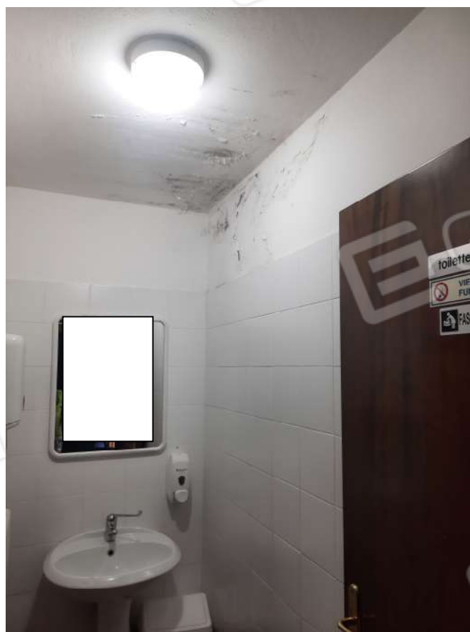
19 – VISTA INTERNA – SERVIZI CON INFILTRAZIONI
