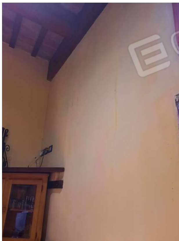
17 – VISTA INTERNA – SALA CON INFILTRAZIONI
