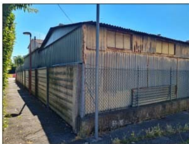
FOTO 11 - VISTA DEL RETRO DAL VIALETTO PEDONALE
