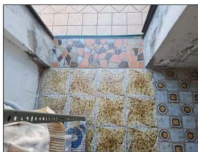
FOTO 50 - DETTAGLIO PAVIMENTI A PIANO TERRA
