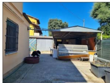
FOTO 18 - VISTA DALL'INGRESSO CARRABILE - TETTOIA
