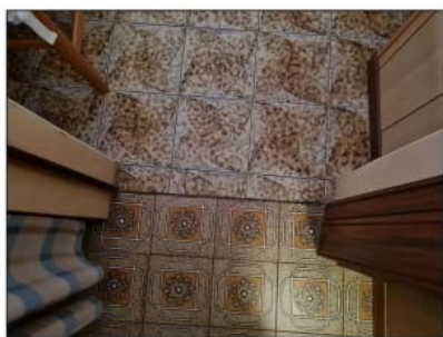
FOTO 49 - DETTAGLIO PAVIMENTI A PIANO TERRA
