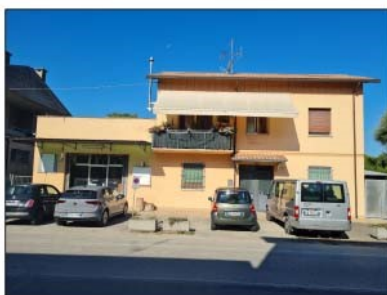
FOTO 05 - FRONTE SU STRADA
