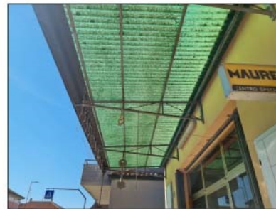
FOTO 27 - TETTOIA INGRESSO NEGOZIO
