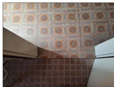
FOTO 51 - DETTAGLIO PAVIMENTI A PIANO TERRA
