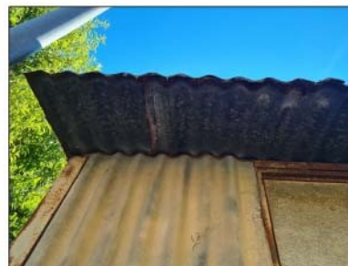
FOTO 56 - VISTA DELLA COPERTURA
