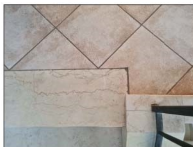
FOTO 71 - DETAGLIO PAVIMENTI PIANO PRIMO
