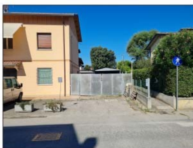
FOTO 08 - INGRESSO CARRABILE E VIALETTO PEDONALE
