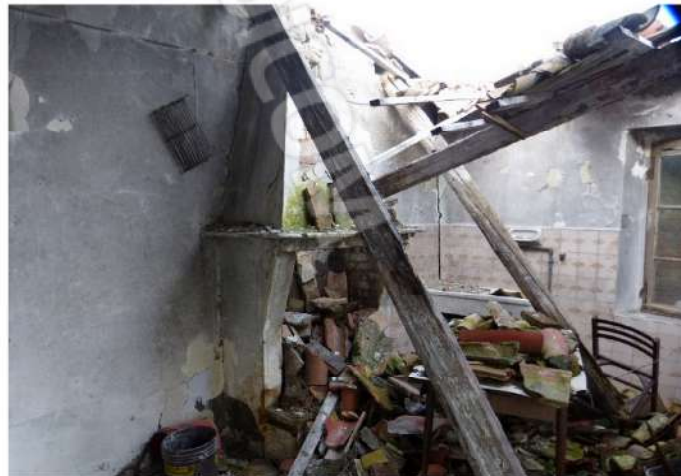
fabbricato principale - particolari porzioni crollate per degrado/instabilità
