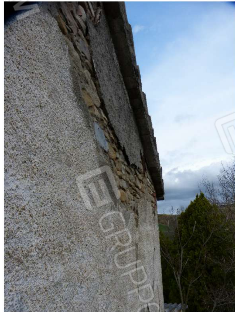
fabbricato principale - particolari porzioni crollate per degrado/instabilità
