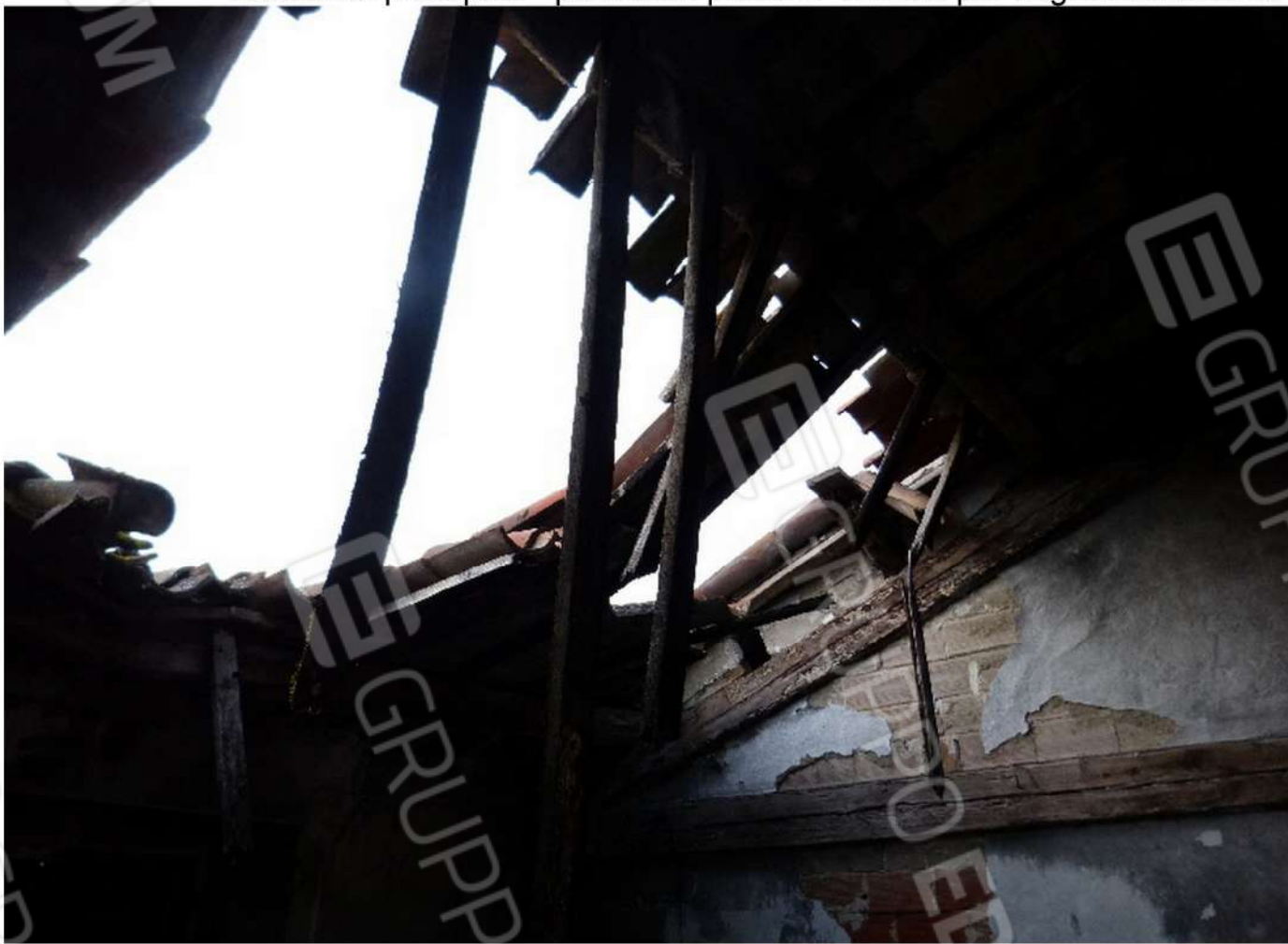
fabbricato principale - particolari porzioni crollate per degrado/instabilità
