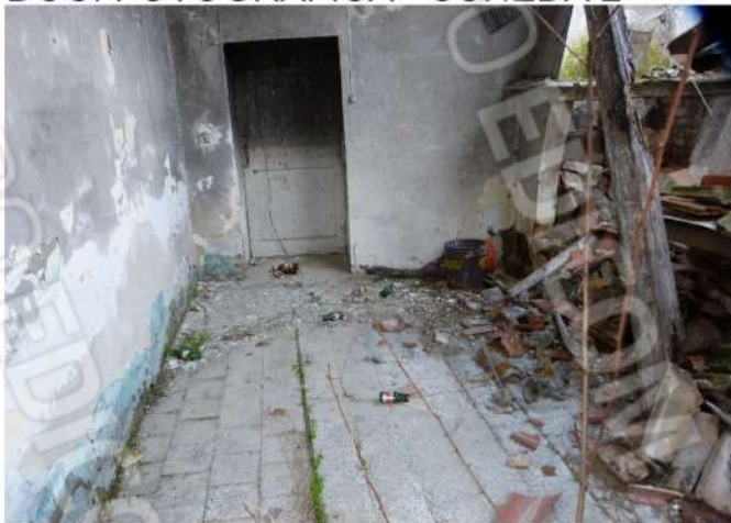
fabbricato principale - particolari porzioni crollate per degrado/instabilità
