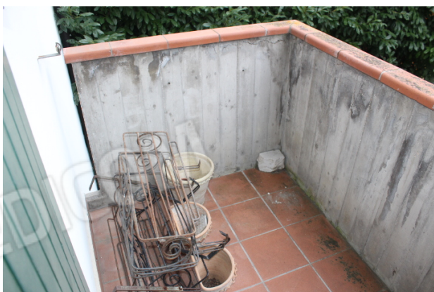
VEDUTA DEL BALCONE CON AFFACCIO SUL RETRO DEL FABBRICATO
