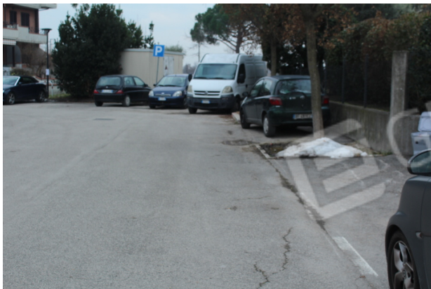
STRADA PUBBLICA VISTA IN DIREZIONE VERSO IL CENTRO DI SAN MAURO PASCOLI
