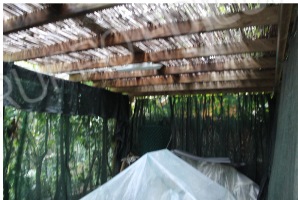
PARTICOLARE DEL PERGOLATO REALIZZATO SULLA CORTE DI PROPRIETA'
