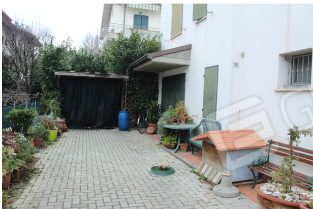
VEDUTA DEL PERGOLATO REALIZZATO SULLA CORTE DI PROPRIETA' E DELL'ACCESSO ALL'AUTORIMESSA
