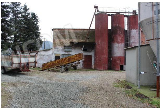
ALLEVAMENTO E SILOS NON RAPPRESENTATI NEI PROGETTI, LATO NORD
