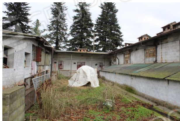
INTERNO FRA DUE CORPI DI ALLEVAMENTO, VISTO DA SUD
