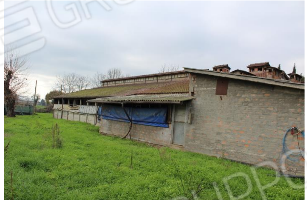
LATO EST, VISTO DA NORD VERSO SUD
