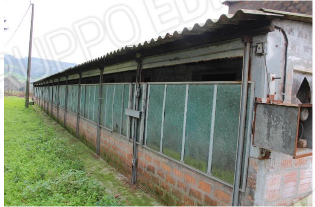
ALLEVAMENTO LATO NORD; SI NOTA LINEA ELETTRICA
