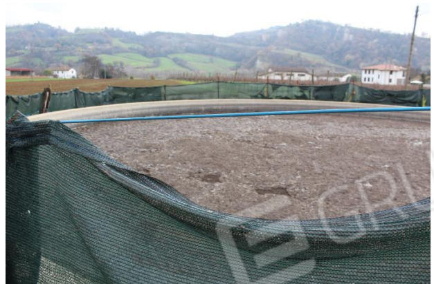
VASCHE DI STOCCAGGIO LIQUAMI
