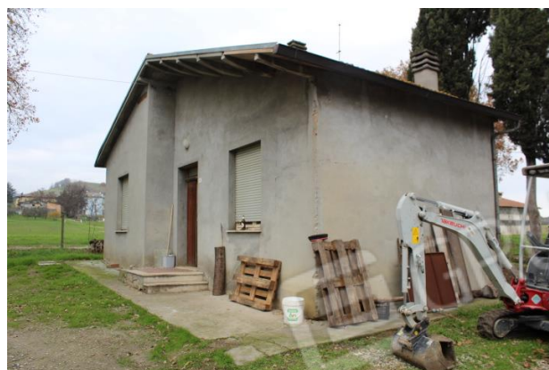
ABITAZIONE PROSPETTO SUD-EST (ora ADIBITA USO UFFICIO-SPOGLIATOIO)
