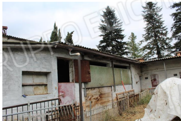
PARTICOLARE LATO SUD
