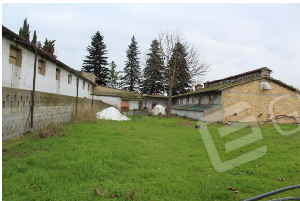
LATO SUD, PARTICOLARE FRA DUE CORPI DI FABBRICA
