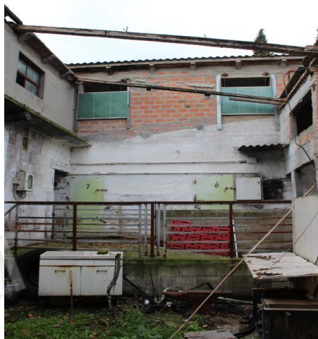
PORTICO IN CORRISPONDENZA DELL'ACCESSO PEDONALE
