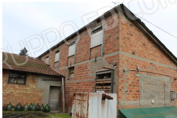
ALLEVAMENTO POSTO A LATO DEL DEPOSITO\MAGAZZENO
