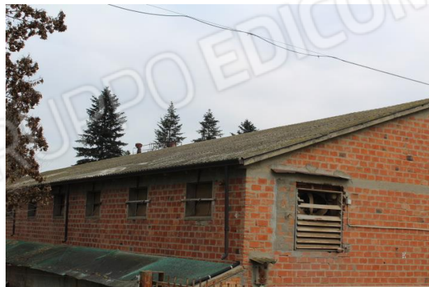
LATO NORD; SI NOTA LA LINEA ELETTRICA IN ATTRaversamento ED IL PARTICOLARE DELLA COPERTURA IN LASTRE DI ETERNIT
