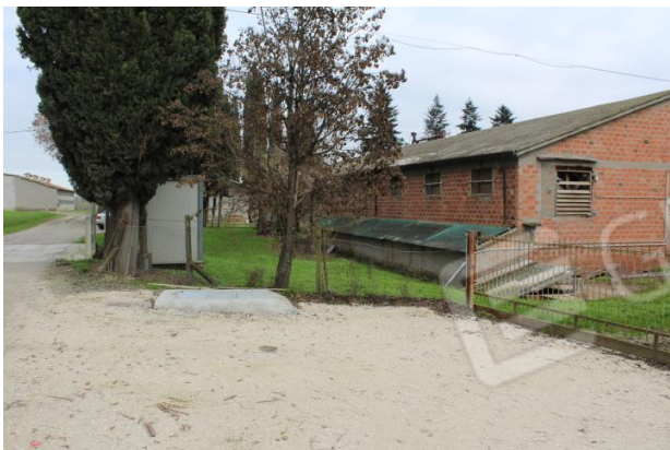
ALLEVAMENTO LATO OVEST, CON MANUFATTO ABUSIVO, CONTENENTE MATERIALE PER DISINFETTARE I MEZZI IN ENTRATA. Si nota la falda con manto di copertura in eternit
