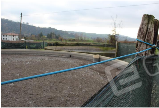
VASCHE DI STOCCAGGIO LIQUAMI
