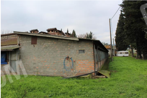
ALLEVAMENTO LATO NORD; SI NOTA LINEA ELETTRICA
