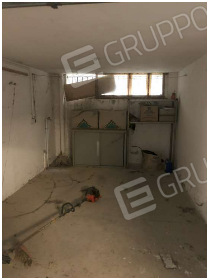
Fg13 part.773 sub. 22 - autorimessa
