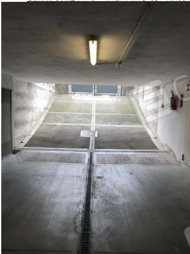
Foto 5- rampa garage condominiale
