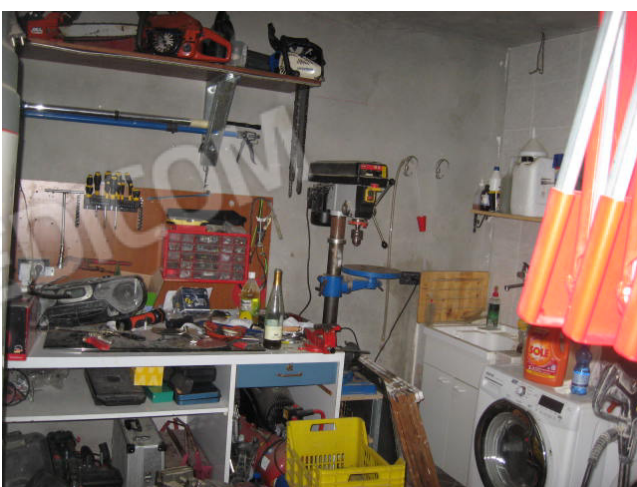
garage e pompa di calore
