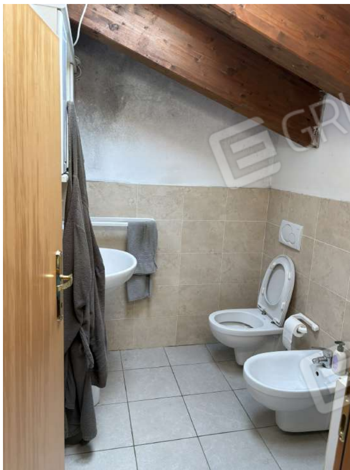
Foto 17- piano secondo – bagno
