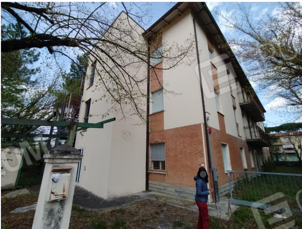
Ingresso al lotto da Via Fornace.
